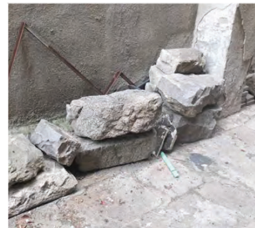
Acopi de material als peus de la façana. Font: GAA 04/08/2021
