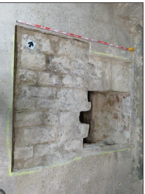
Ampliació de la cala i paviment UE 204
