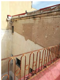
Obertura tapiada en badalot d'escala. Barana oxidada. Font: GAA 15/10/2021
