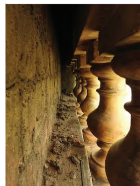
Balustres de ceràmica de la barana de coberta. Doble barana d'envanet de maó. Font: GAA 03/09/2021
