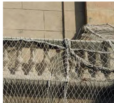
Xarxa de protecció en en la barana de balustres de planta primera per possibles desprendiments de materials. Font: GAA 03/08/2021
