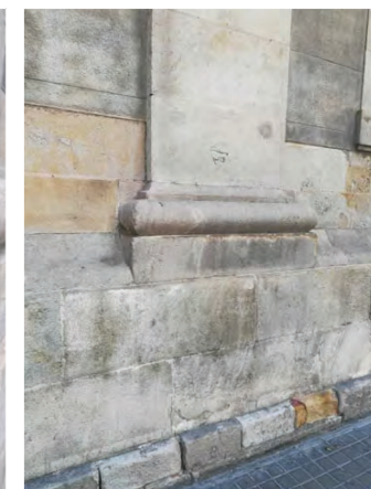
Alteració cromàtica de la pedra de Montjuïc del basament. Font: GAA 03/08/2021
