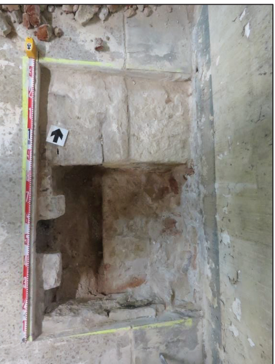
Banqueta de fonamentació UE 208
