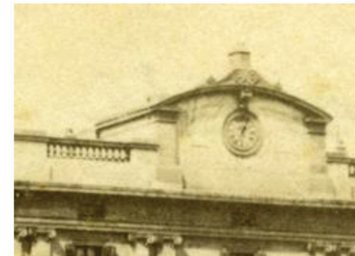
Fotografies de l'estat actual de l'edifici. A la imatge superior: vista de peu pla de la façana principal, a la imatge central: es pot observar l'escultura d'Al·legories del Comerç i la Indústria. A la imatge inferior: Evidències fotogràfiques de la prolongació del cos del rellotge que ja constava en els plànols de Mestres. Font: arquitecturacatalana.cat
