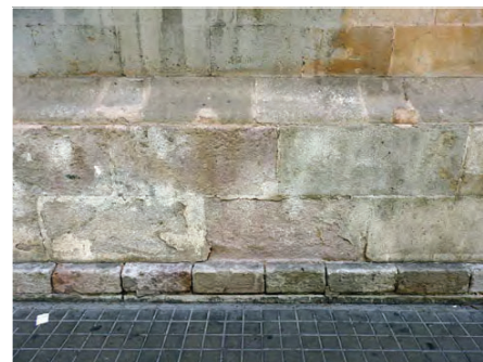
Pèrdua de secció de les pedres de Montjuïc del basament. Reparacions posteriors amb materials disconformes. Font: GAA 03/08/2021
