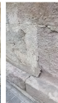
Pèrdua de secció de les pedres de Montjuïc del basament. Reparacions posteriors amb materials disconformes. Font: GAA 03/08/2021
