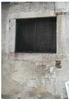
Volum disconforme sobreixint per sobre de la façana. Font: GAA 03/08/2021
