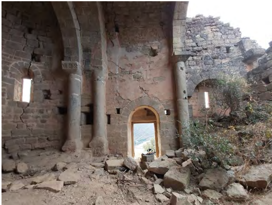
Ruïnes de l'església de Sant Joan de Torrelblanca, propera a Ponts, on també hi ha absidioles embegudes en el gruix del mur, i columnes de suport dels arcs del presbiteri
