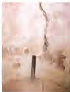
Escletxa de del la volta del sostre. Torre consolidada. Foto, Ll. Cuspinera, E. Solsona. 2016.
