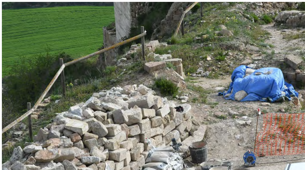
Materials constructius, procedents del desenfonsament de l'església, estibats al pati del Castell, contenint carreus de gres (església), carreus de gres (campanar i muralla), i carreus de guix (muralla).
