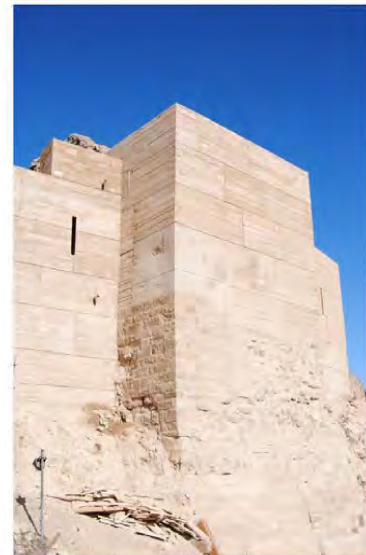
Torre de la muralla sud-.est amb els murs erosionats. Obra restaurada amb la restitució dels morters de calç formant les tapieres. Foto, E. Solsona. 2009, 2016.
