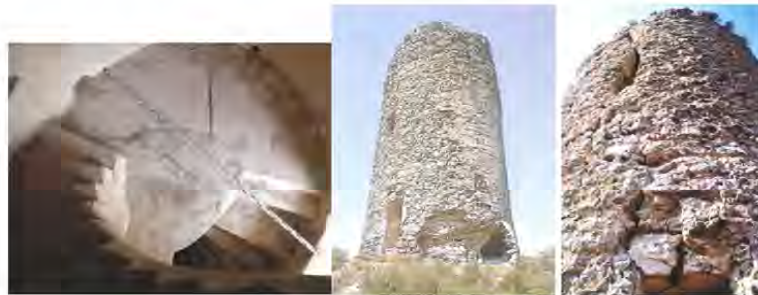
Escalles. Paraments erosionats, restes del mur encofrat i esclatxa de l'estructura de les façanes i de les voltes del les tres alçades. Foto, L. Cuspinera. 2006.
