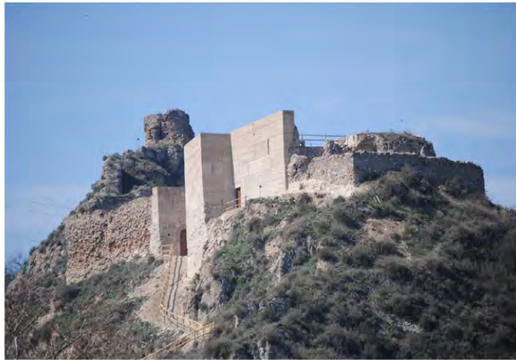
Façana sud amb les portes de la muralla. Foto, E. Solsona. 2016.
