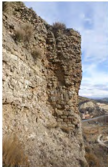
Torre de la muralla sud-.est amb els murs erosionats. Obra restaurada amb la restitució dels morters de calç formant les tapieres. Foto, E. Solsona. 2009, 2016.
