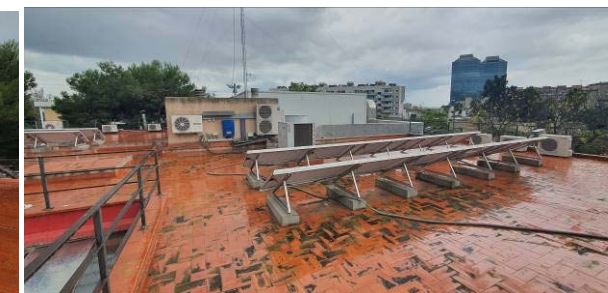
Plaques solars. Instal·lació sobre volum sobreafegit.
