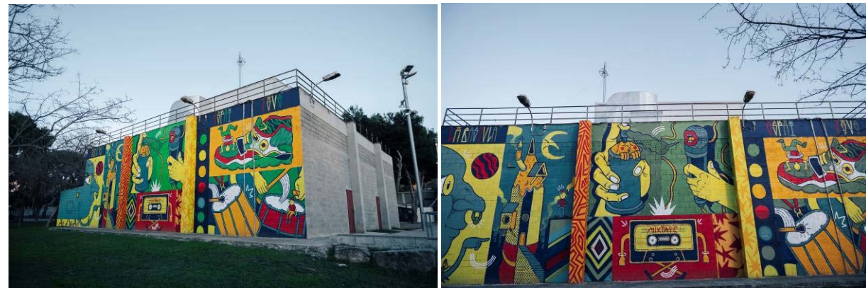
Imatge general de l'edifici
