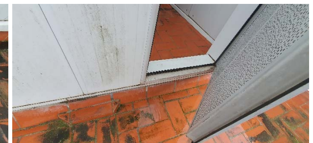
Remat inferior exterior
