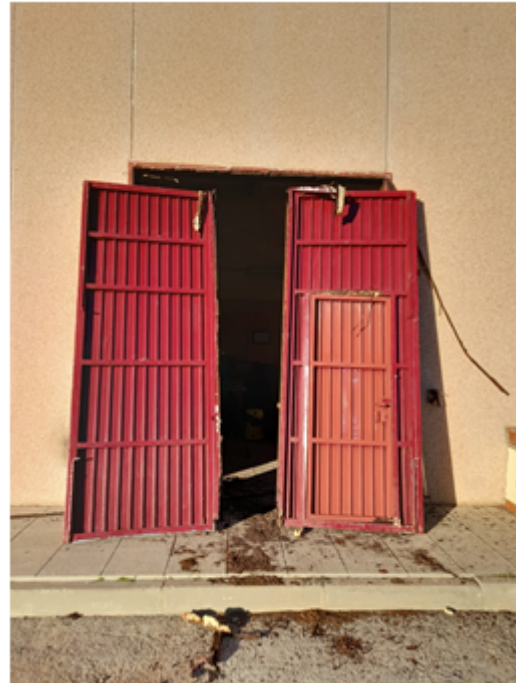
Figures 4 i 5. Detall de l'estat de la porta d'accés existent al taller.
