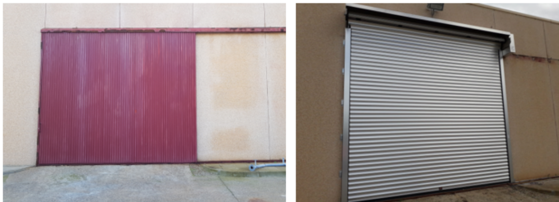
Figures 2 i 3. Detall de la porta d'accés a la sala de deshidratació abans (esquerra) i després de la seva substitució (dreta).
