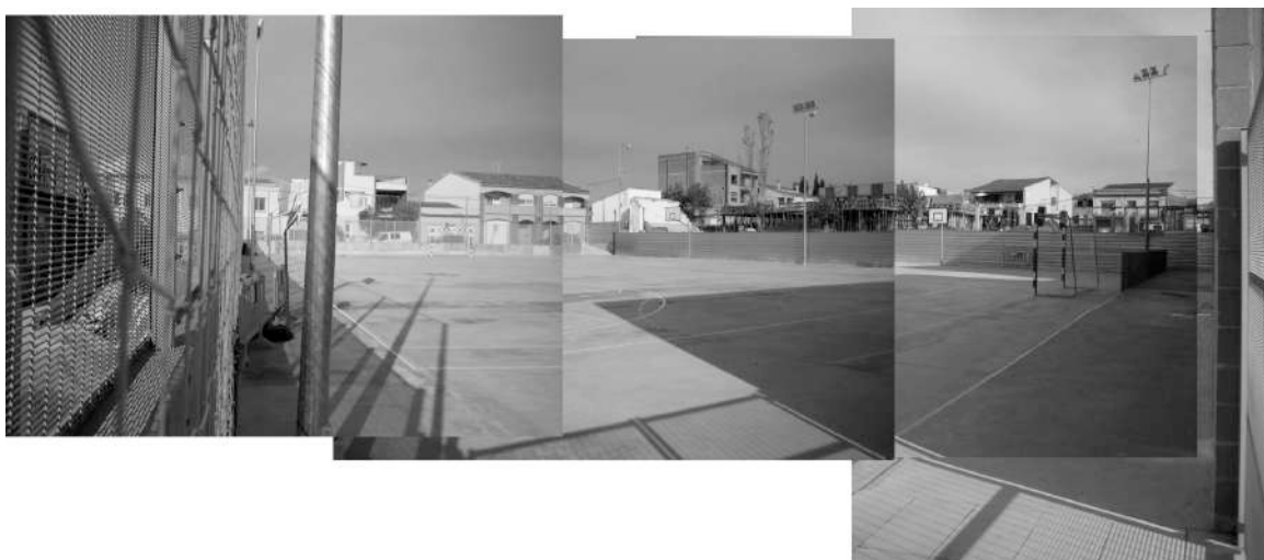
[la pista de l'escola des de l'interior de l'escola, tocant el gimnàs, durant la construcció de la segona fase]
