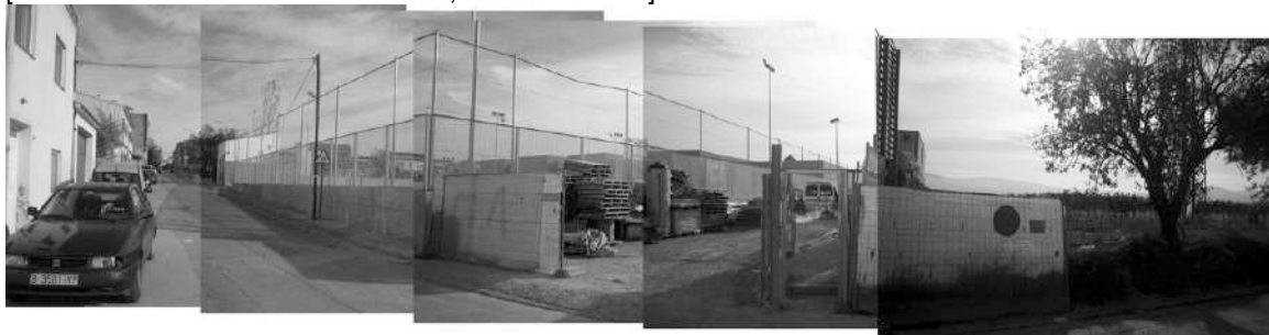
[la pista de l'escola des de la cantonada sud-oest al carrer Sant Roc durant la construcció de la segona fase]
