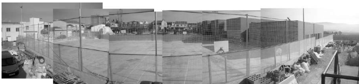
[la pista de l'escola des del sud durant la construcció de la segona fase]
