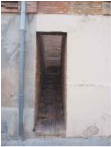
02. ESCALES ACCÉS TERRASSA
