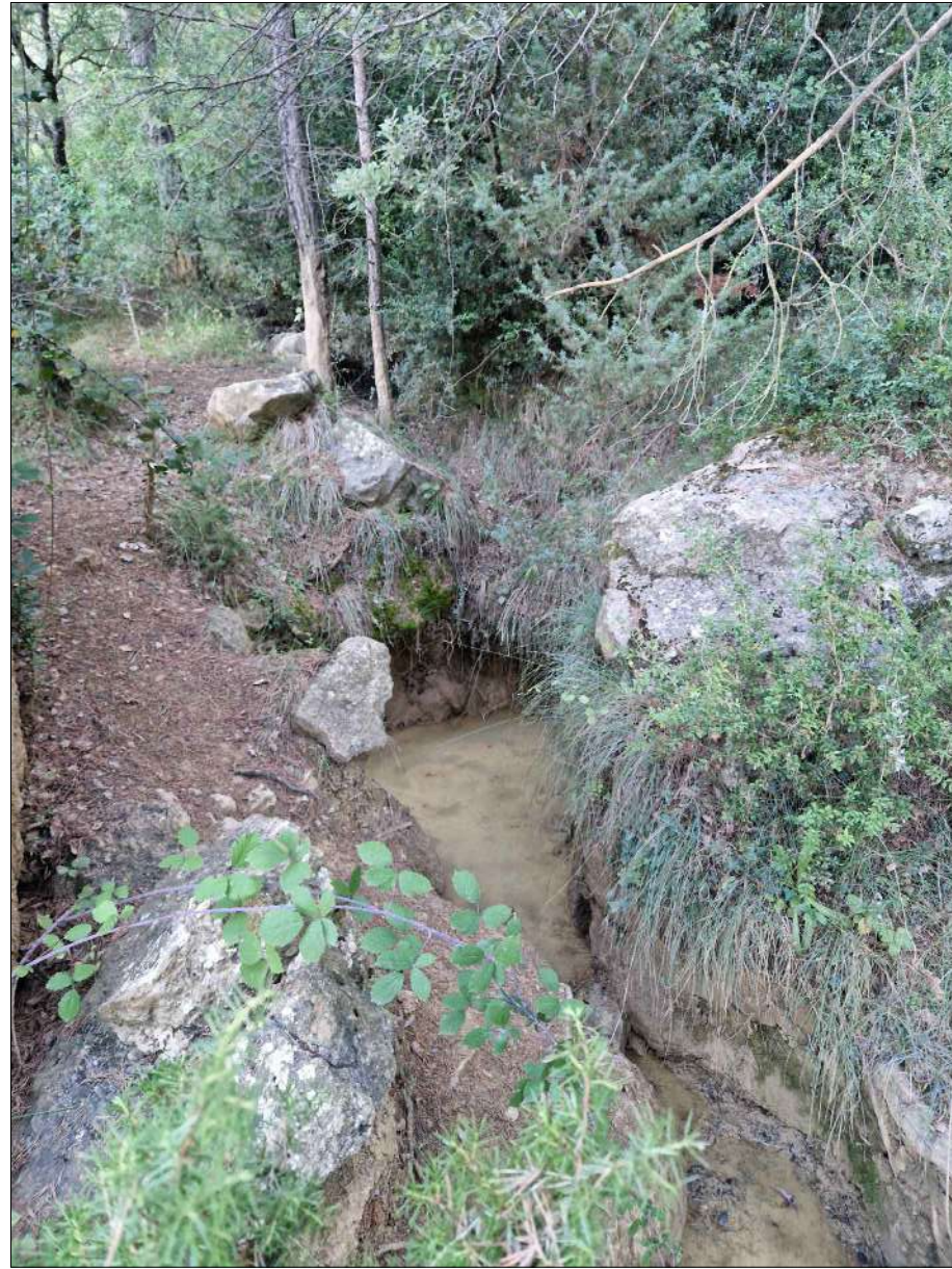
Imatge de la captació. Estat actual
