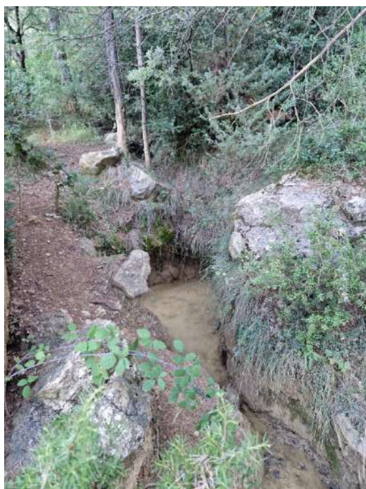
Il·lustració 1: Estat actual de la captació
