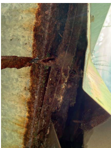
Fotografies de l'estat actual de la coberta
