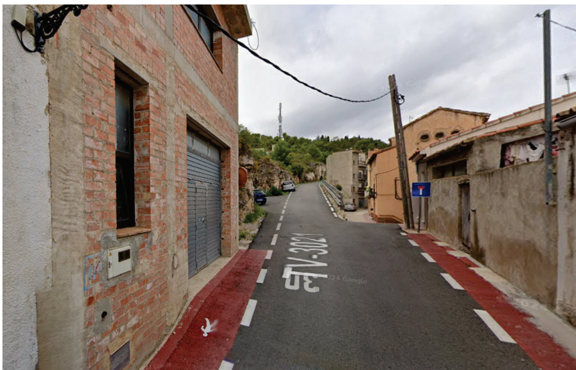
Foto 8. Tram renovació xarxa Carretera de Cardó – Carrer Parral. Punt mig
