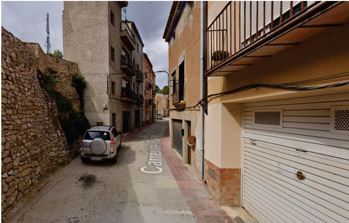
Foto 9. Tram renovació xarxa Carretera de Cardó – Carrer Parral. Punt final
