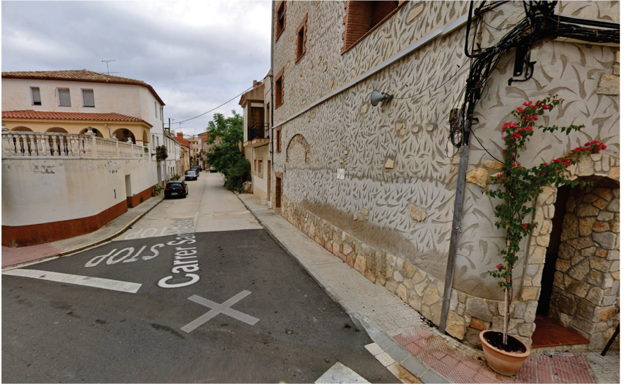
Foto 3. Ubicació vàlvula sector Miravet
