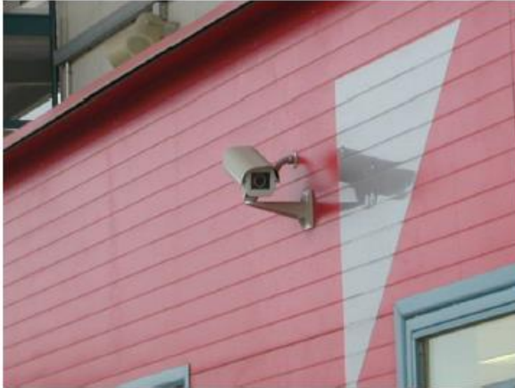
Control local de càmeres a l'intercanviador de Quatre camins
