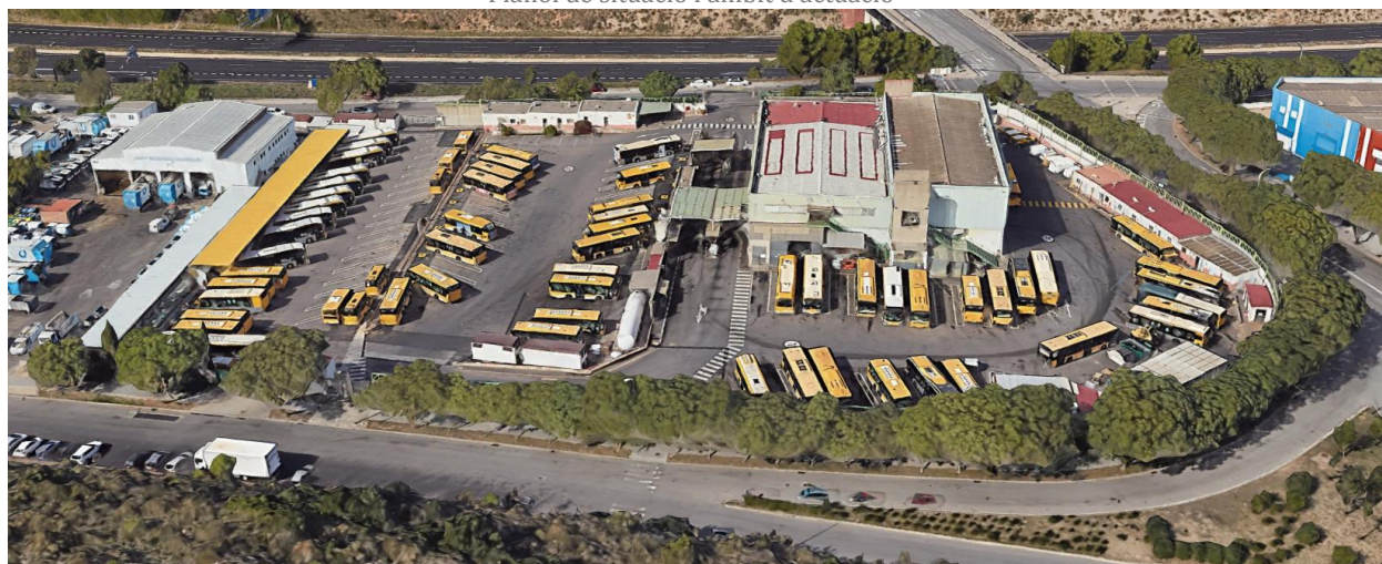
Vista d'emplaçament de les instal·lacions de la cotxera de Badalona, al costat de la B-20
