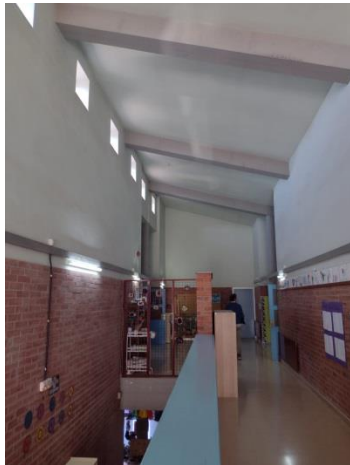
ZONA INTERIOR ESCOLA
