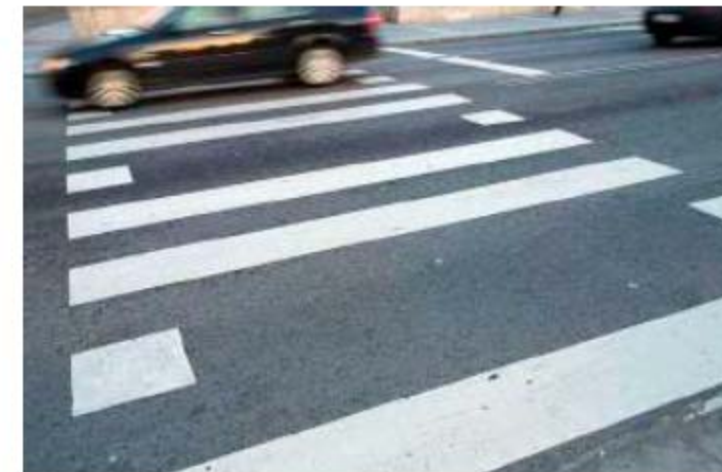
Figura 125. Pas de vianants amb reducció de pintura.
