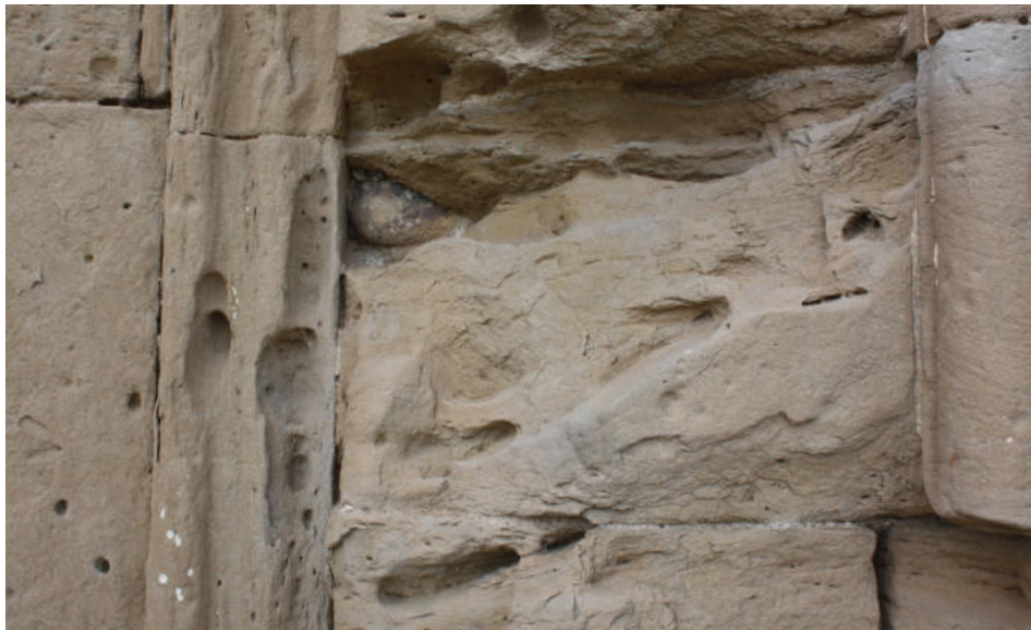
La portalada consta de juntes fines on s'observa la presència de calç i l'àrid de tonalitat gris.
