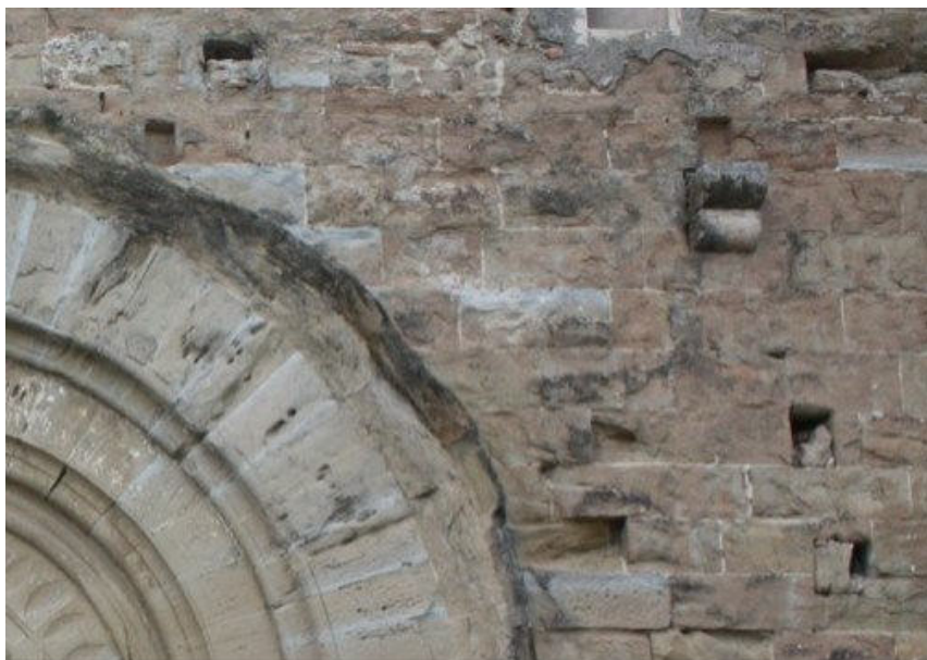
Contrast cromàtic entre les superfícies de la portalada i del parament arquitectònic fruit de les diferències petrològiques entre el material utilitzat.
