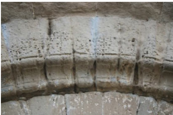
Dues àrees de la portalada amb una greu afectació per alveolització del material lapidi.
