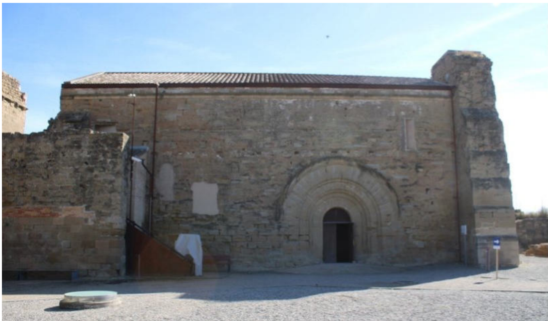
Aspecte actual de la façana principal de l'església de Sta. Maria de Gardeny.
