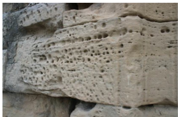
Dues àrees de la portalada amb una greu afectació per alveolització del material lapidi.
