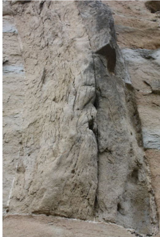
Detall del guardapols afectat tant per un procés d'exfoliació del suport petri com per la presència de colonització biològica.
