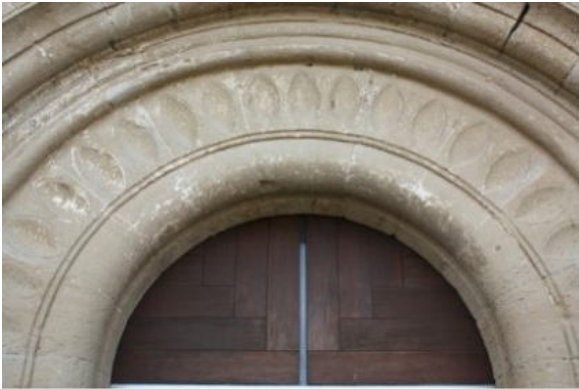
Detall de la decoració vegetal que embelleix la primera arcuació de la portalada. A la dreta, disposició de les dovelles amb una junta de calç que no supera els 5 mm de gruix.
