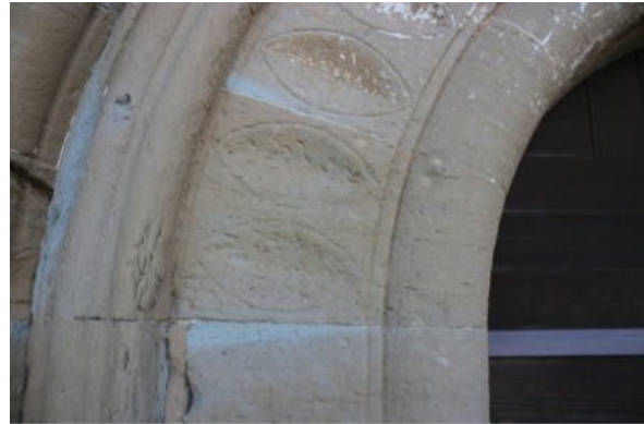
Detall de la decoració vegetal que embelleix la primera arcuació de la portalada. A la dreta, disposició de les dovelles amb una junta de calç que no supera els 5 mm de gruix.
