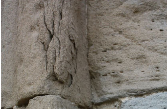
Exemples de descamacions de diferents proporcions als brancals i a les dovelles de la darrera arcuació de la portalada.
