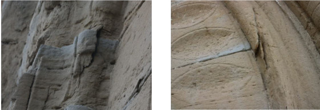
Dos detalls del despreniment de material localitzats a la cantonada d'un carreu que compon el contrafort dret i en la motllura de la tercera arquivolta de la portalada.
