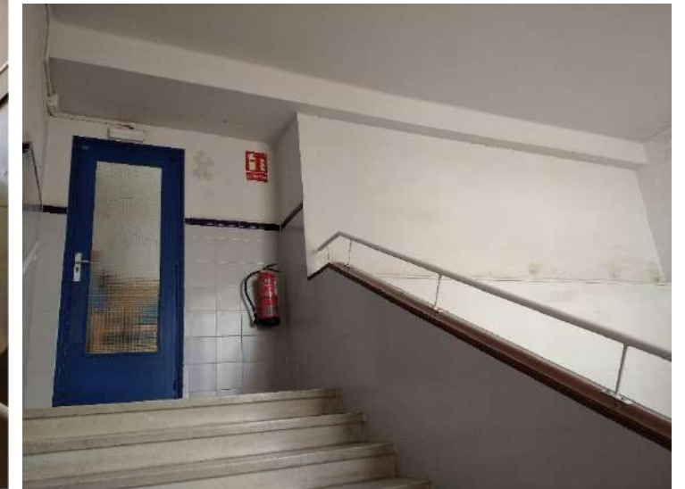
Escaleres a P2
