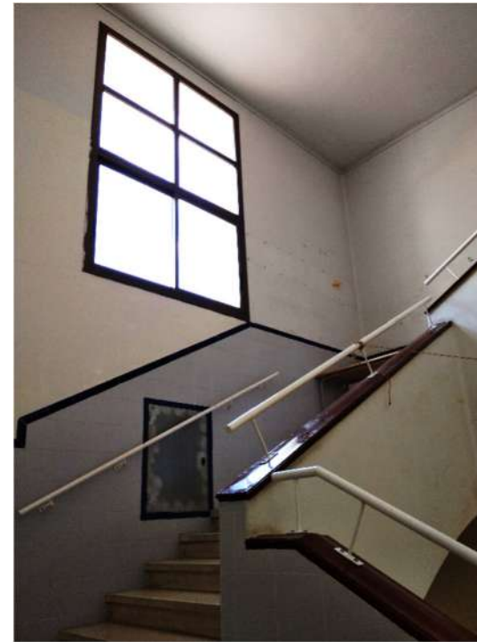
Escaleres a P2
