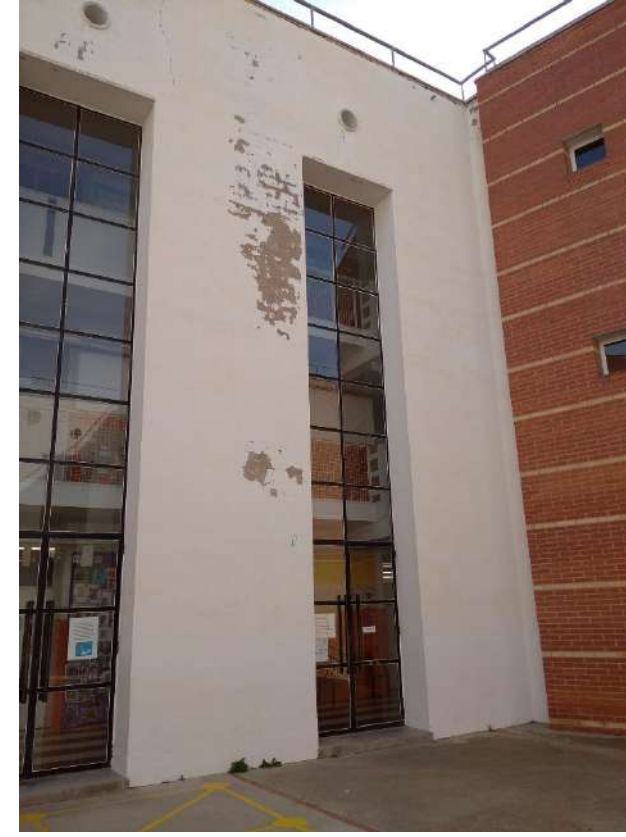
Pati interior, cara oest i cara nord
