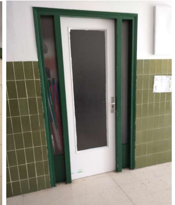
Edifici vermell, neteja
