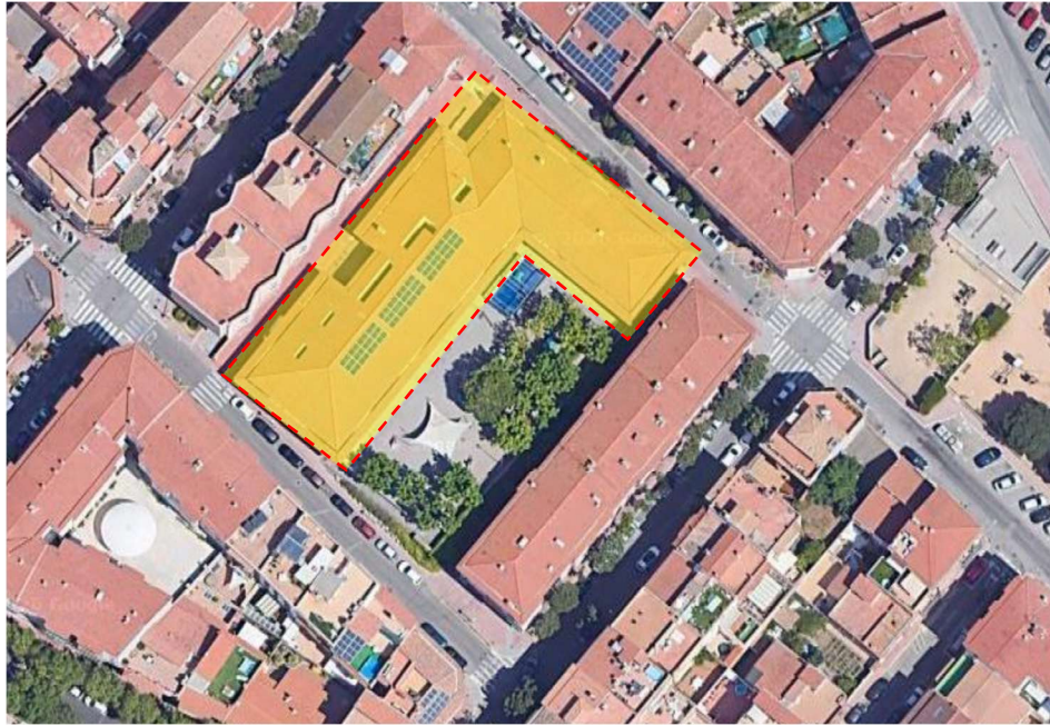
Edifici a climatitzar
