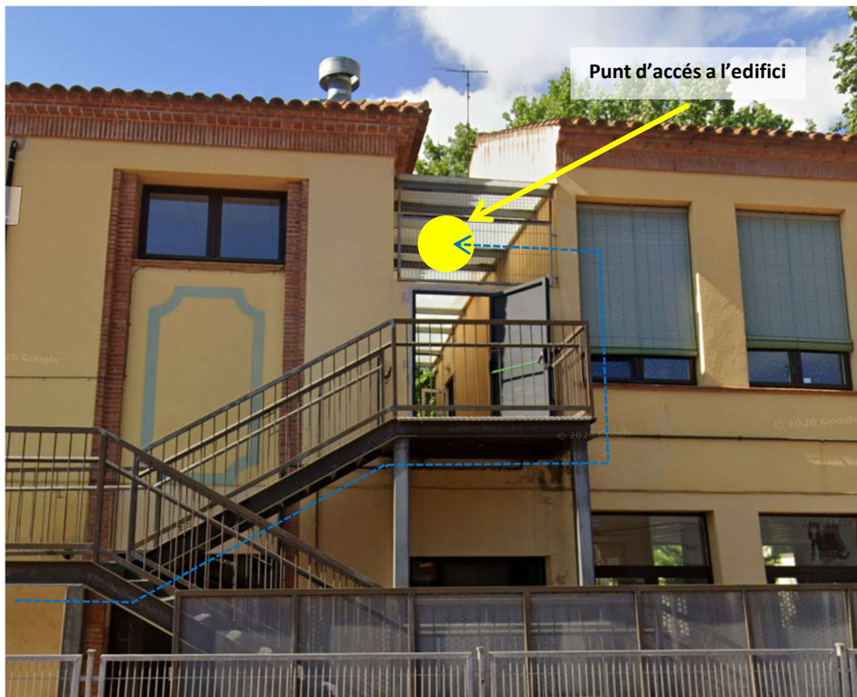
Accés conductes a l'edifici
