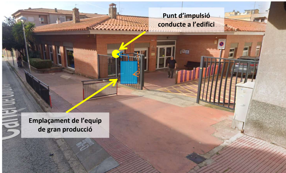
Accés conductes a l'edifici
