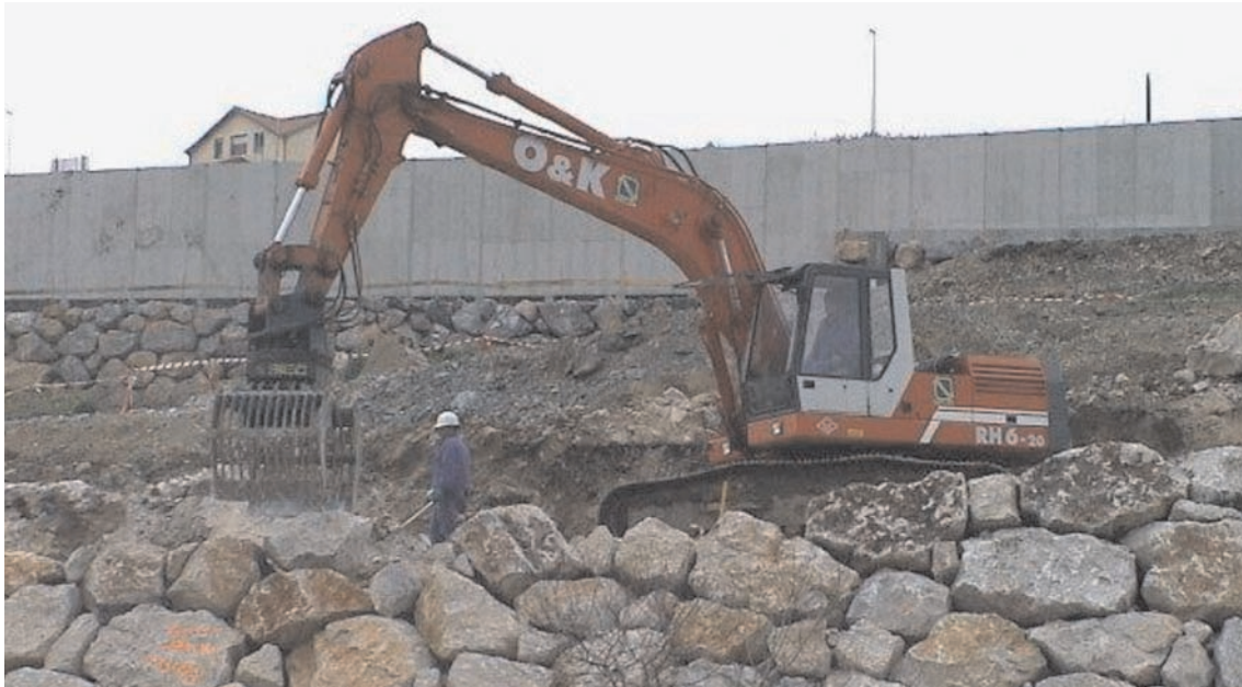
FIGURA 5.8. EJECUCIÓN MEDIANTE EXCAVADORA CON PINZA.
