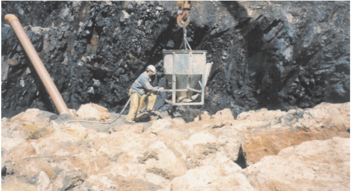
FIGURA 5.4. HORMIGONADO DE LA CIMENTACIÓN.
