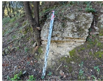
Fot. 9. Blocs de conglomerats situat a la zona superior del vessant. Es recomana el seu sanejament o ancoratge.
