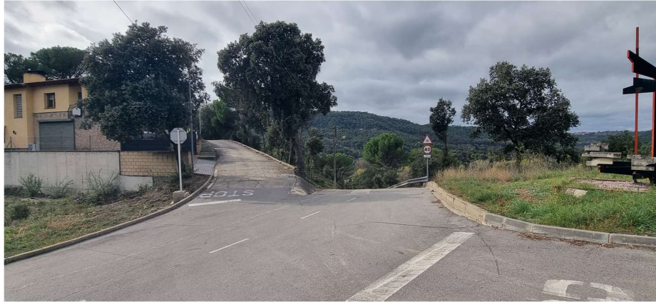
Unió Carrer Canigó amb Pujada dels Lladres direcció B-124
