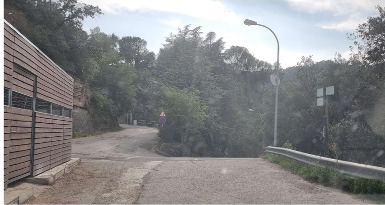
Fotografia direcció B124 amb unió C/del Cementiri lateral esquerre
