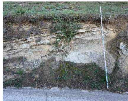
Fot. 11. Nivells estratificats a la zona superior del talús. Es recomana sanejar els que puguin esdevenir inestables i situar una berma en aquesta zona que puguin contenir els blocs que es desestabilitzin i evacuar les aigües d'escorrentia.
