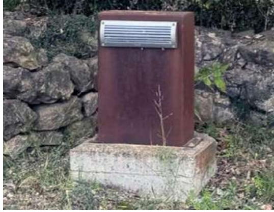
Imatge de les basees i caixes de suport de les lluminàries existents.
