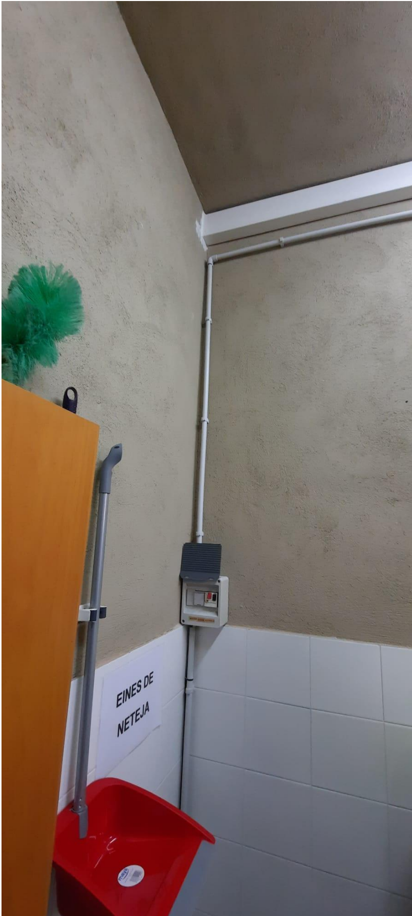
Construcció d'una caseta pel dipòsit d'aigua potable a l'EDAR de Solivella. Projecte
