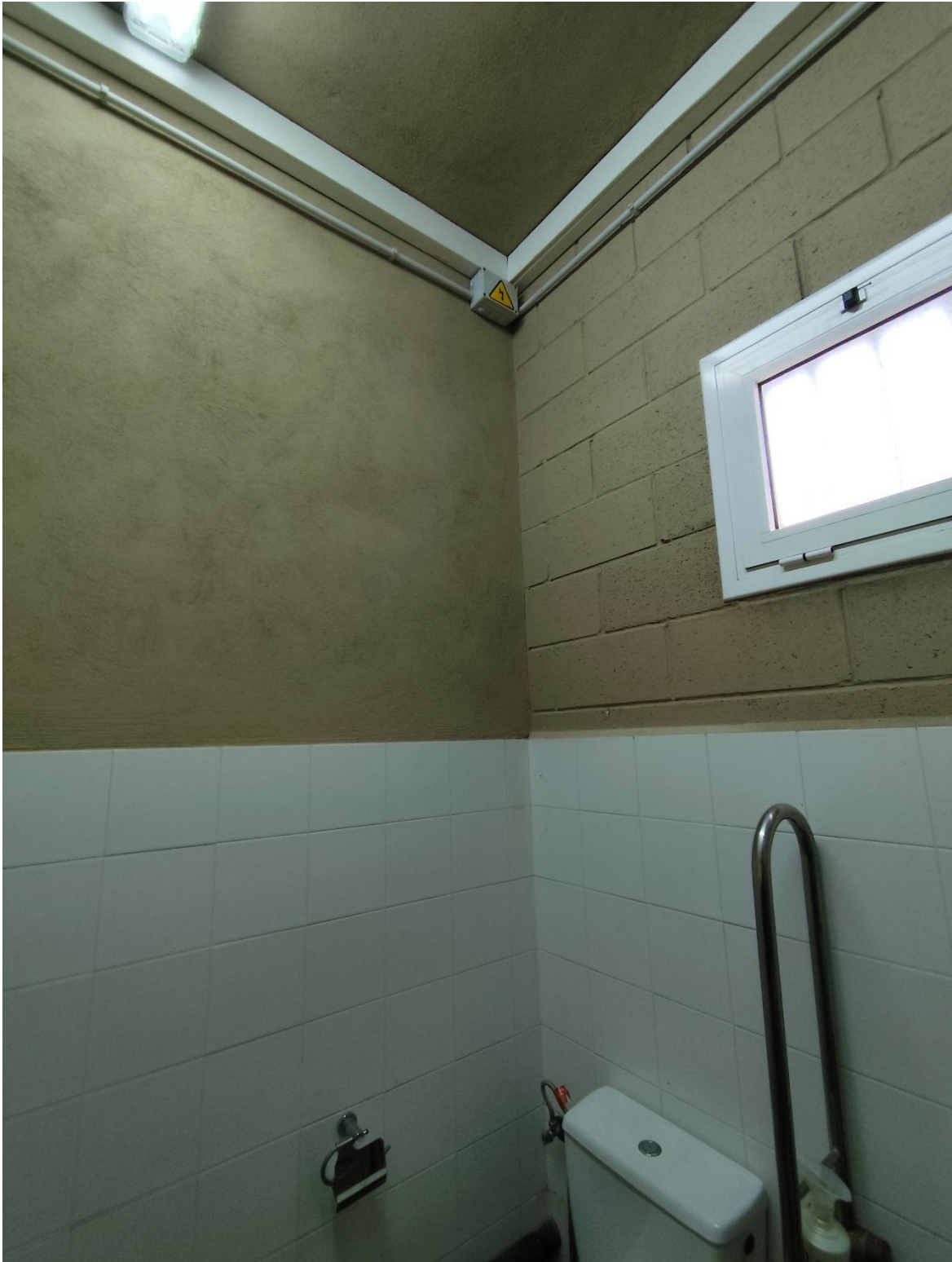
Il·lustració 5. Estat actual cambra de bany per on es traurà la línia elèctrica.
