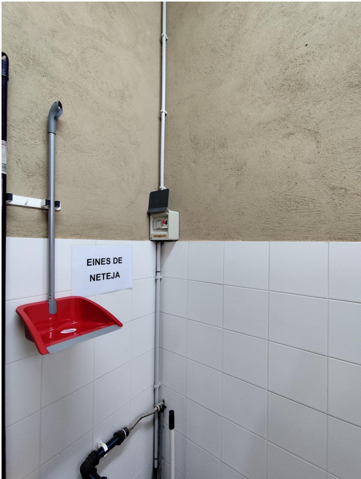
Il·lustració 6. Protecció IDEM a la que es col·locarà abans de treure la línia elèctrica a la caseta tot foradant paret.
