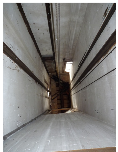
Recinte ascensor actual
