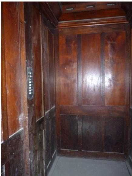
Cabina ascensor actual fora de servei
