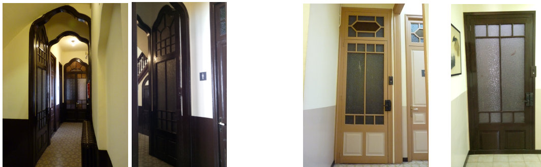
Detalls de les portes de l'ascensor a la planta baixa i en les plantes pis.
