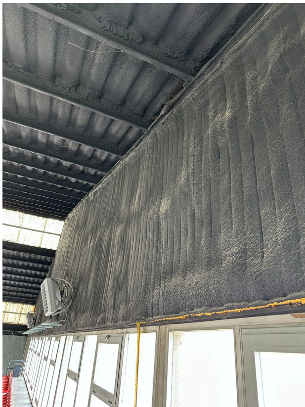
Acabado interior faldones laterales fachadas Este y Oeste (proyectado de poliuretano pintado)
