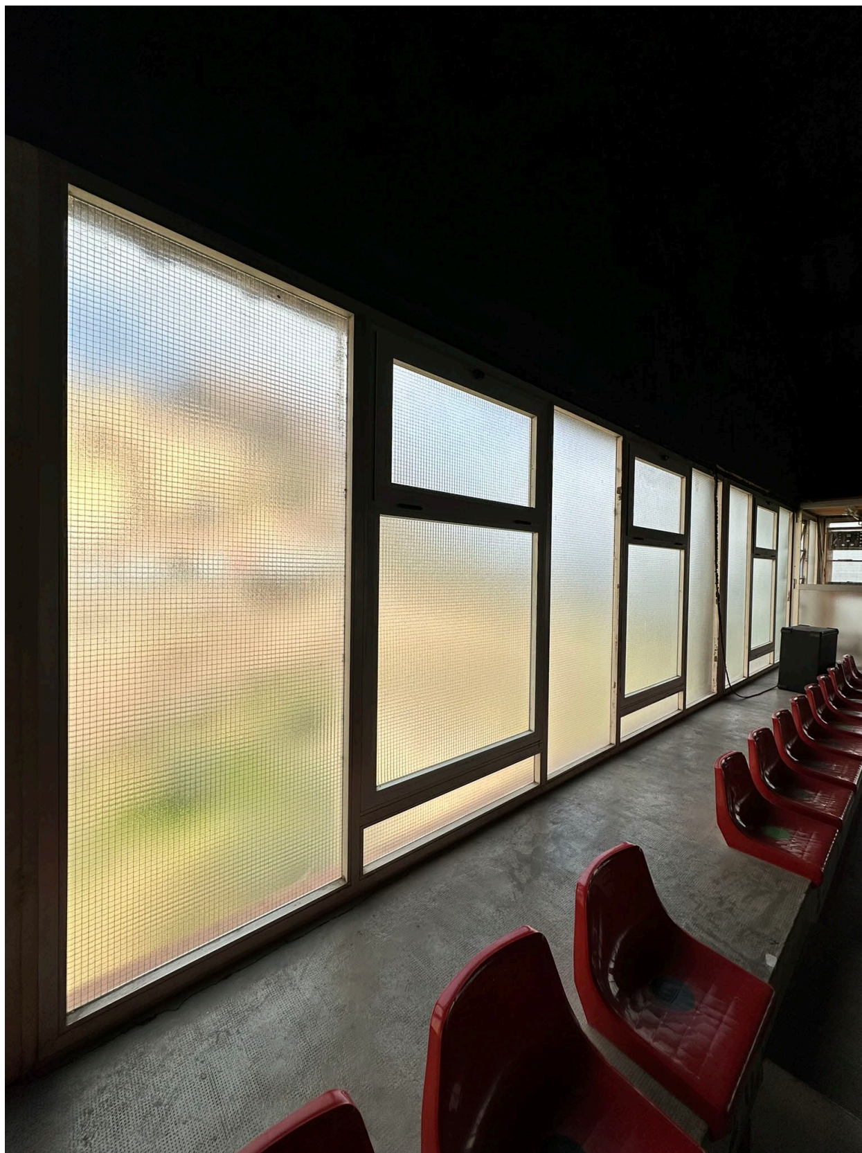
Ventanas de aluminio sin RPT con vidrio simple armado.
