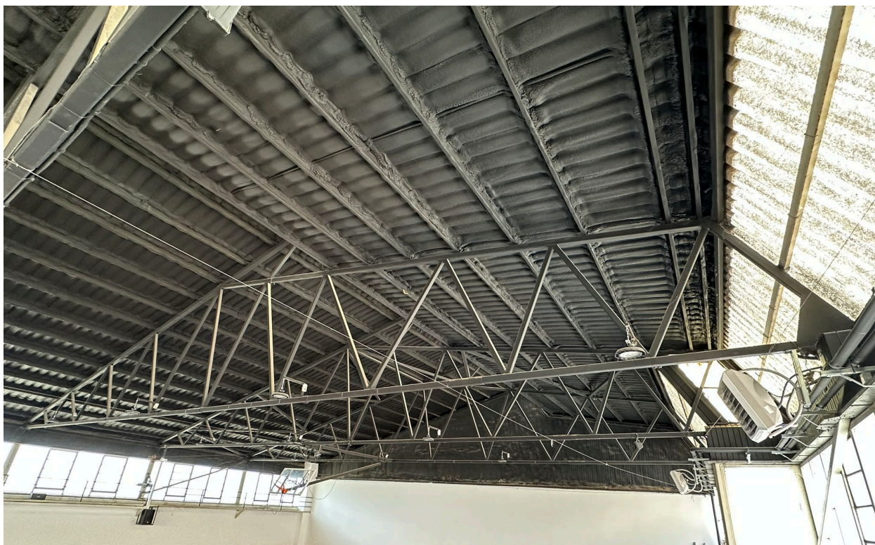
Interior cubierta pabellón, cerchas metálicas, correas y panel de cubierta.
