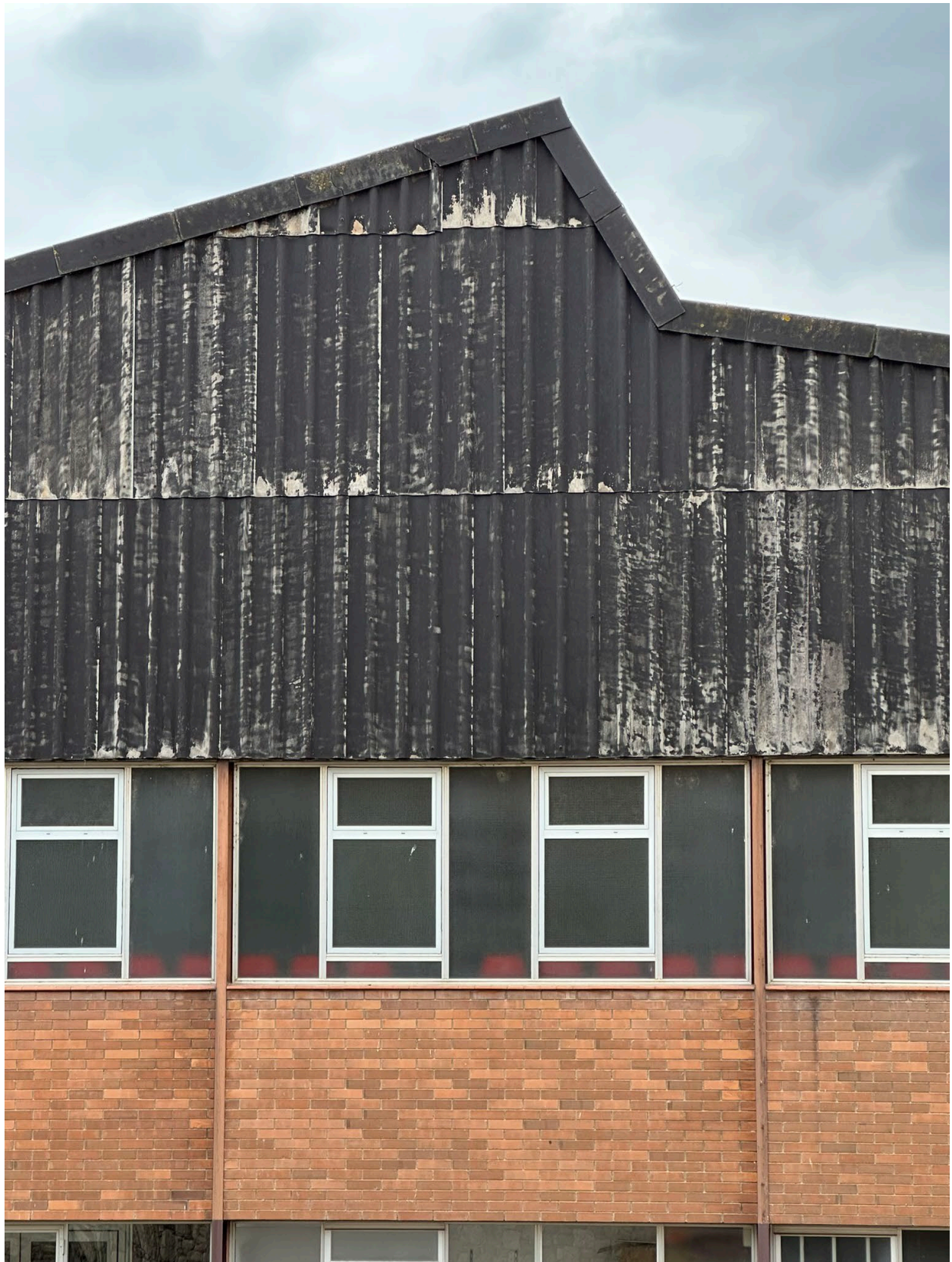
Fachada Este, material de cubierta (placas de fibrocemento) en faldón Este.
