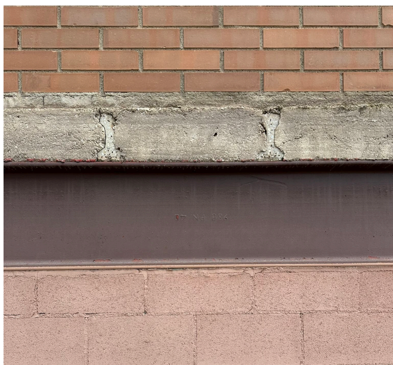
Acabado exterior del forjado de la pista del Pabellón (Fachada Oeste)
