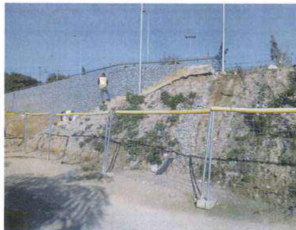
Figura 5: Talús on s'ha executat l'estabilització
