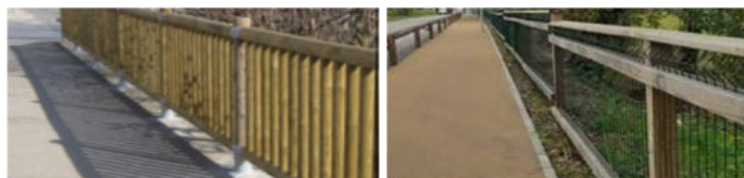
Barana de fusta
