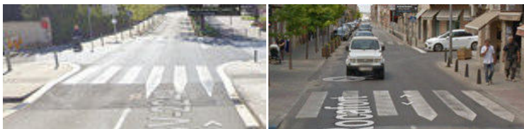
Plataforma reductora de velocitat en cruïlla
