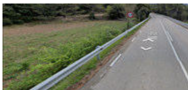
Biona (Metèl·lica, de fusta)
