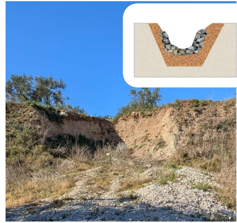
Arranjament talús erosionat: baixant empedrat (E1 i E2)
