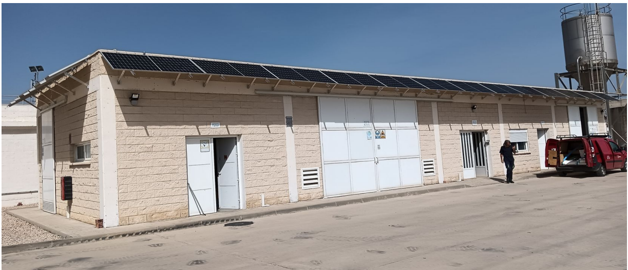
Imatge 2. Vista de plaques FV en marquesina metàl·lica instal·lades en zona frontal tal com es marca en el present criteri.
