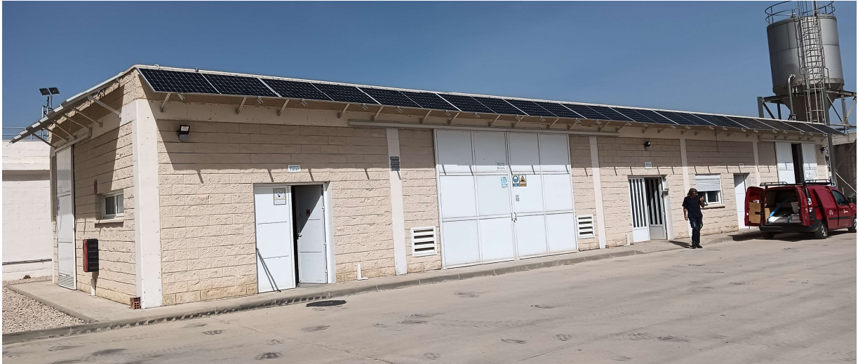
Imatge 2. Vista de plaques FV en marquesina metàl·lica instal·lades en zona frontal tal com es marca en la present millora.
