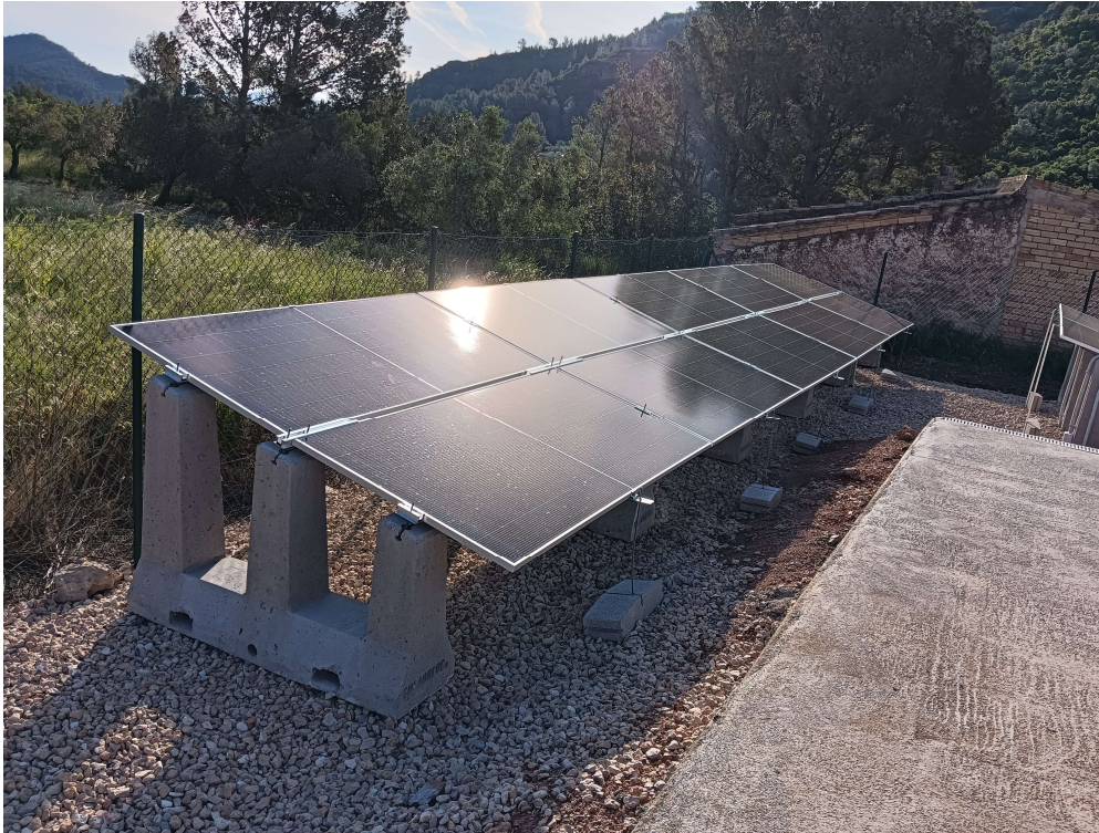
Imatge 5. Plaques FV tipus a instal·lar per a l'execució de la millora.
