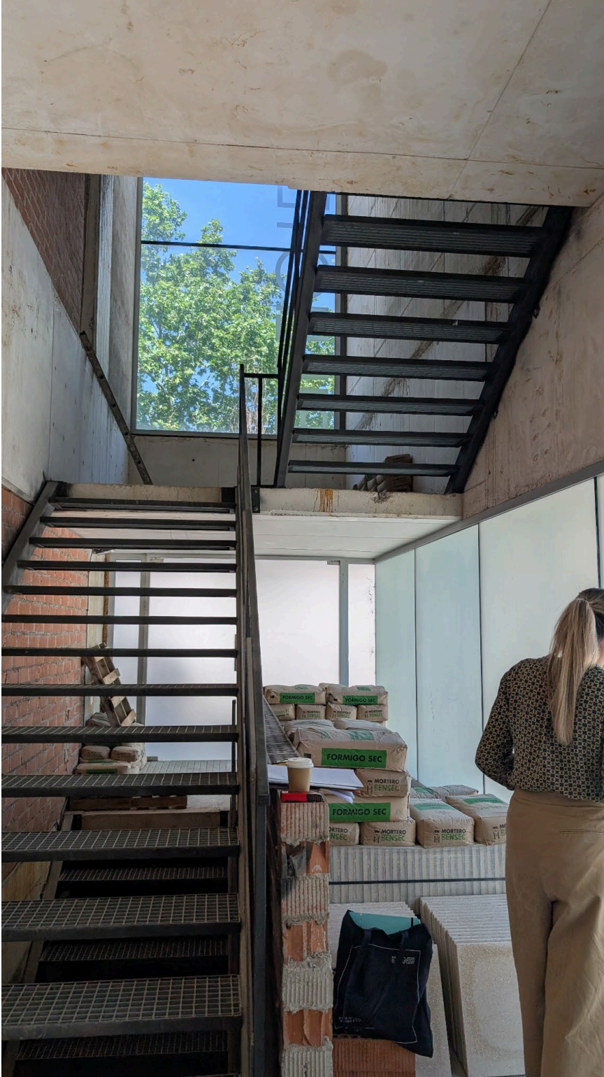
Escala d'accés entre plantes amb envidrament lateral i sacs d'obra.
