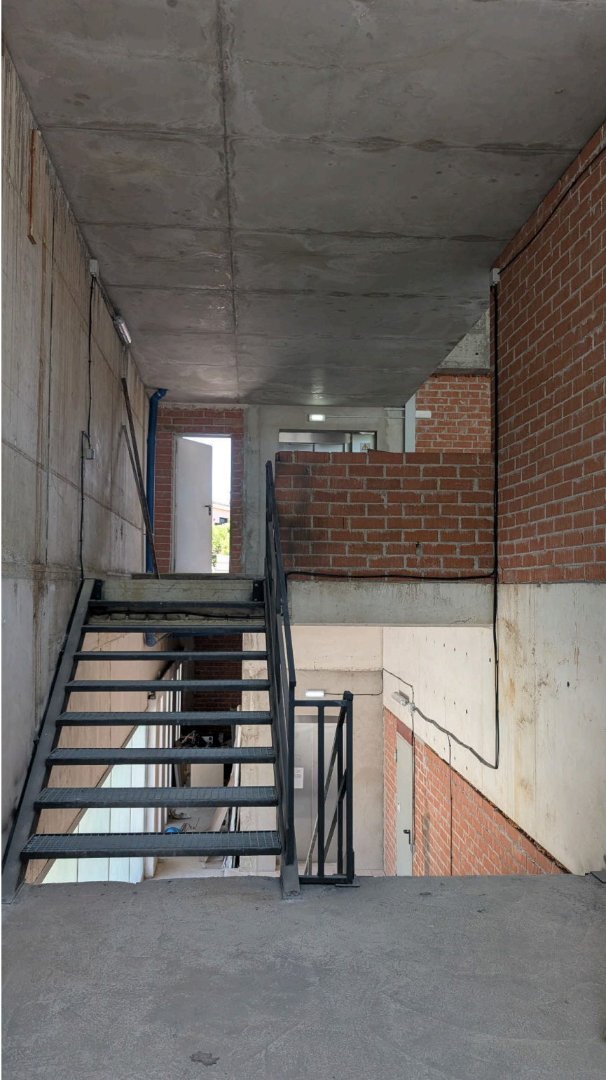
Vista superior de l'escala interior i accés a planta primera.
