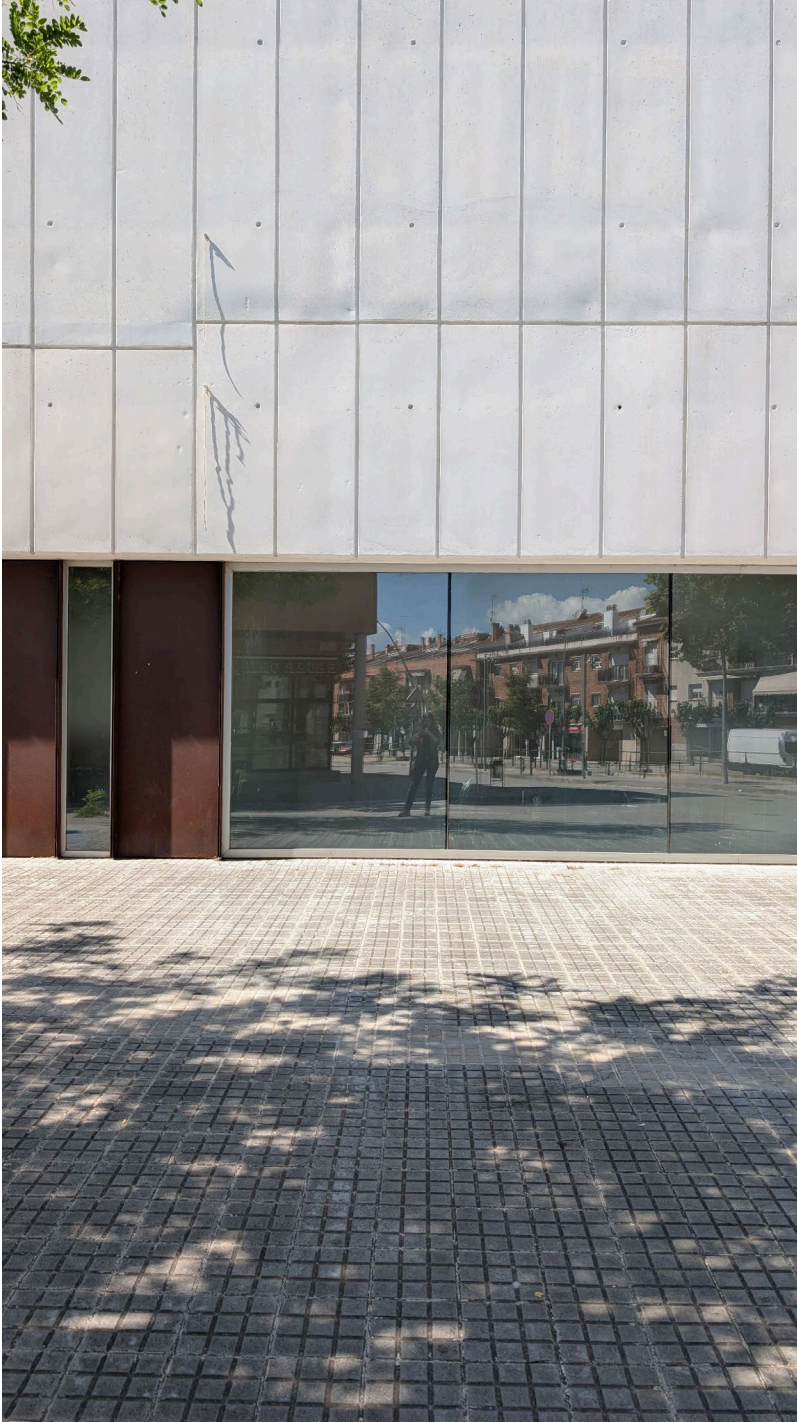
Façana principal amb envidrament a doble alçada i acabats de formigó vist.
