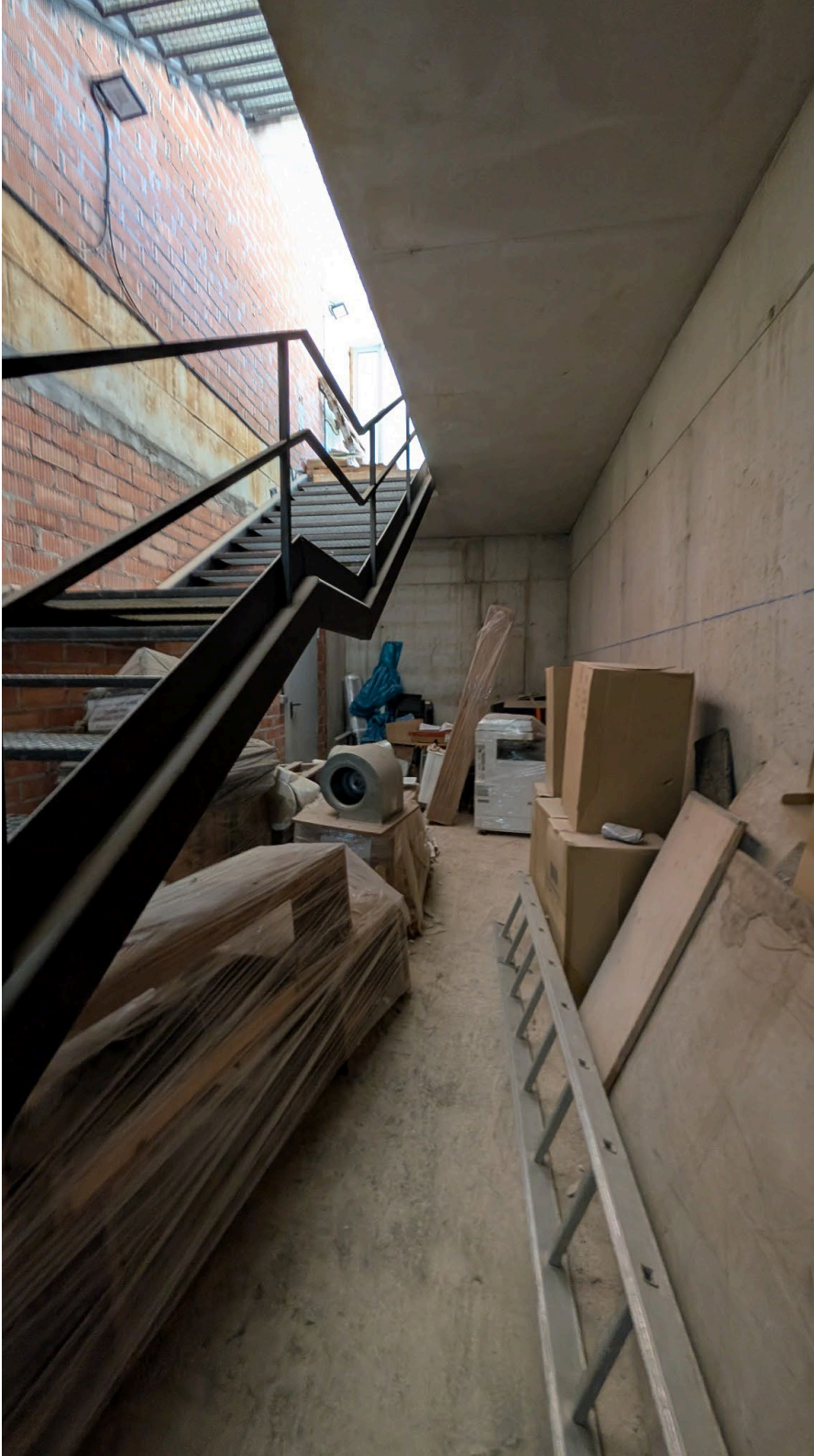
Zona d'emmagatzematge provisional a l'interior, sota l'escala. S'observa com l'escala de PB a P1 està anclada a la paret de tancament.
