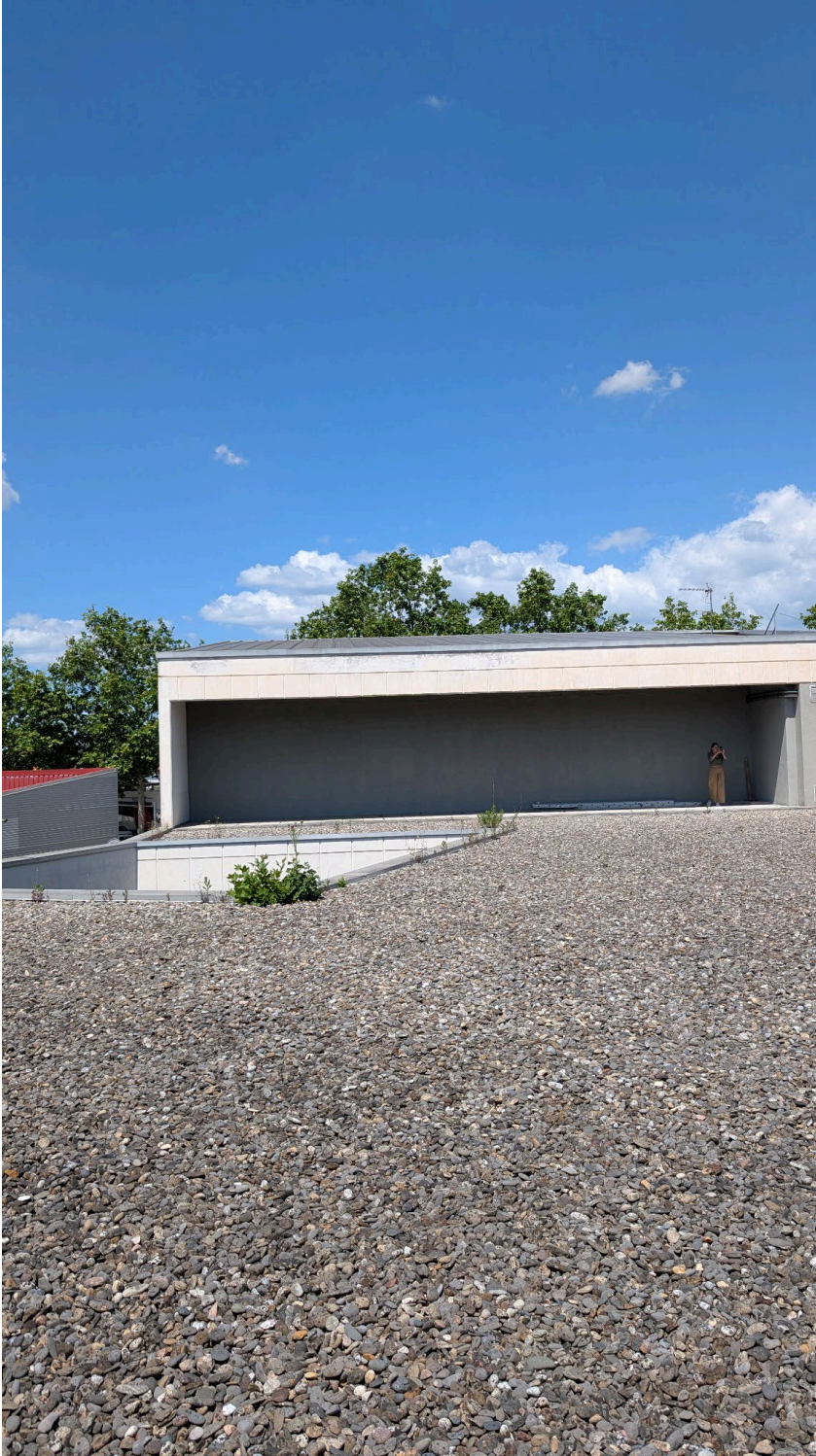
Coberta plana acabada amb grava, amb visió de la caixa d'escala emergent. Façana posterior de la sala
