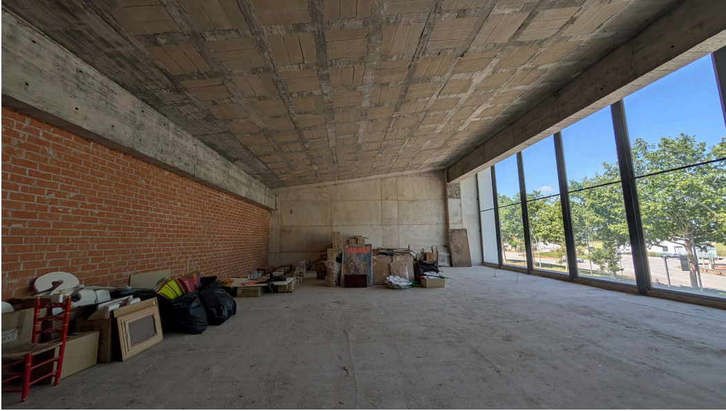
Espai interior de la futura sala polivalent a la planta primera.
