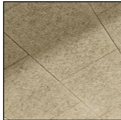
F01: Fals sostre registrable Fals sostre amb guia vista d'acer galvanitzat i panell de fibra de fusta reciclada tamany 120x60cm tipus Heraklith o equivalent.
