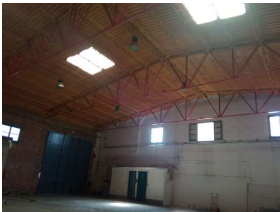
Interior nau accessible des del carrer Indústria
