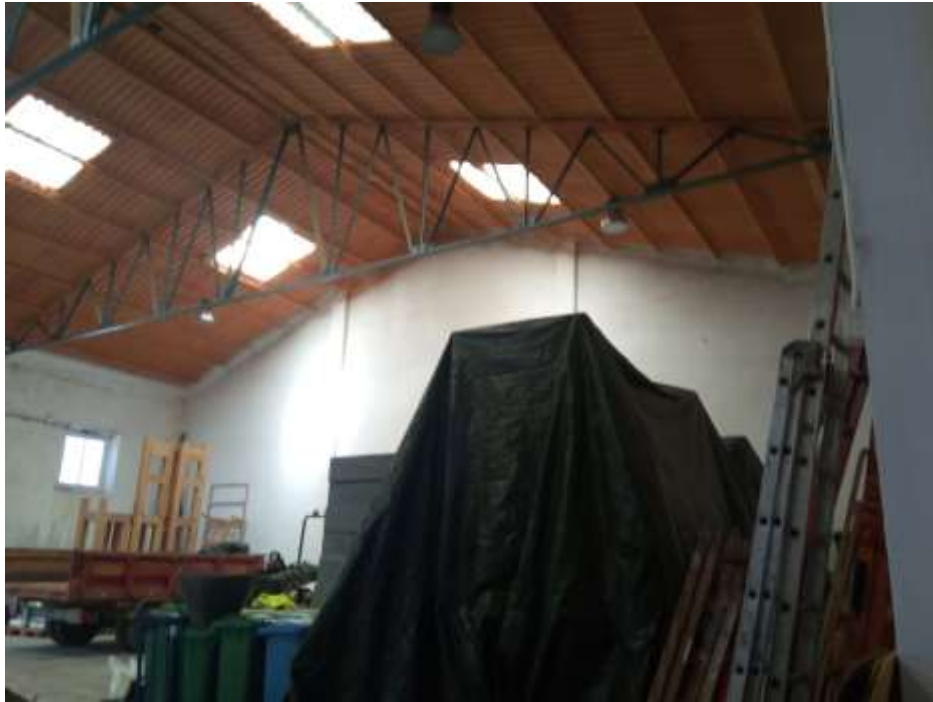
Interior nau accessible des del carrer Pau Casals
