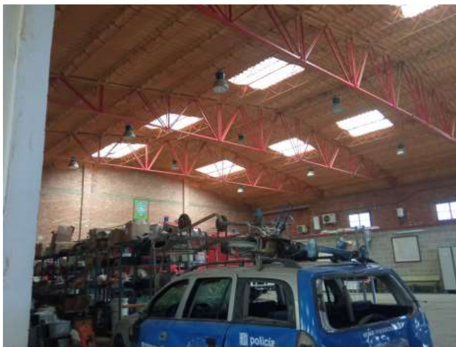
Interior nau accessible des del carrer Indústria
