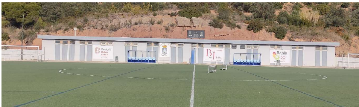
Edifici de vestidors sobre el que es col·locarà el cartell amb el nom del camp
