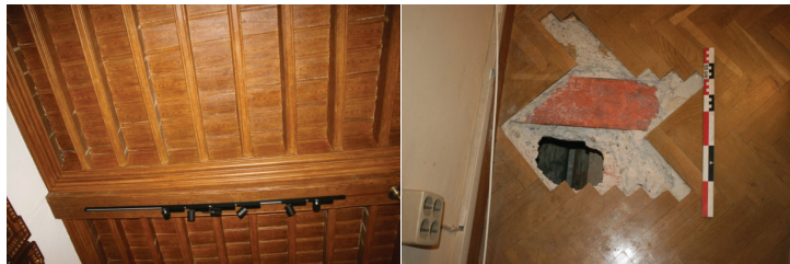
P3 E6 S15 Vistes del sostre i de la composició de la part superior del forjat.
