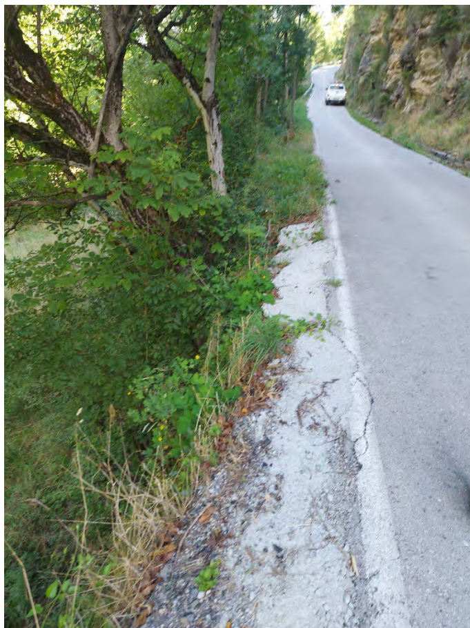
Fotografia núm. 6 - p.k. 0+630 Biona amb nova imposta i clavada 72 m
