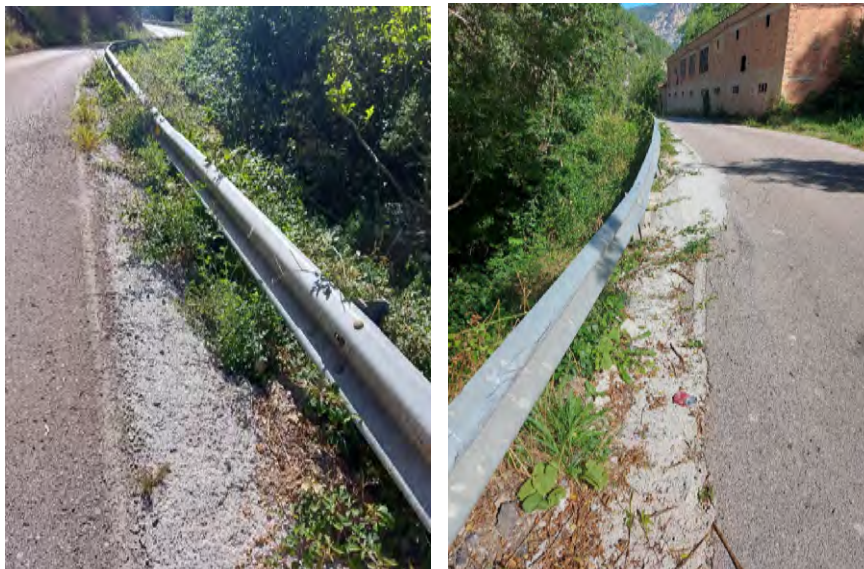
Substitució de barrera biona existent p.k. 0+300 i p.k. 0+510, per desplaçament de la mateixa en el cap de talús.
