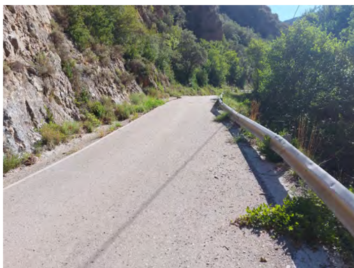
Substitució de barrera biona existent, p.k. 0+250 pel seu mal estat.
