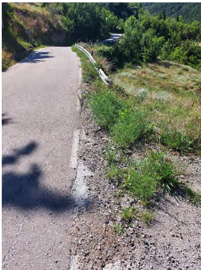
Fotografia núm. 12 - p.k. 1+510 Biona amb dau 16 m
