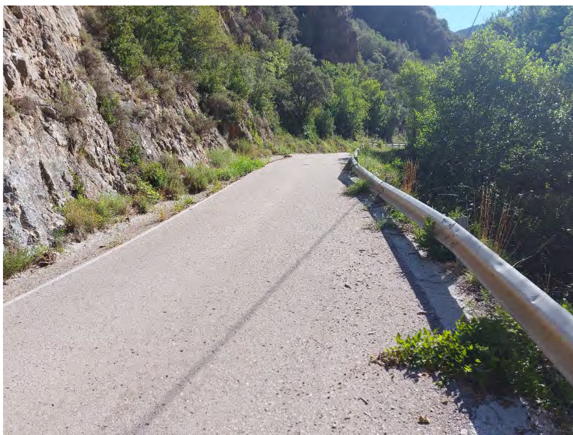
Fotografia núm. 2 - p.k. 0+250 Repàs 8 m biona, desmuntatge i substitució biona
