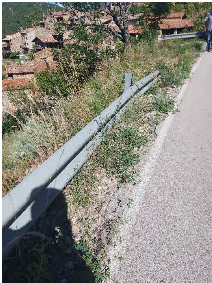
Fotografia núm. 11 - p.k. 1+510 Biona amb dau 16 m
