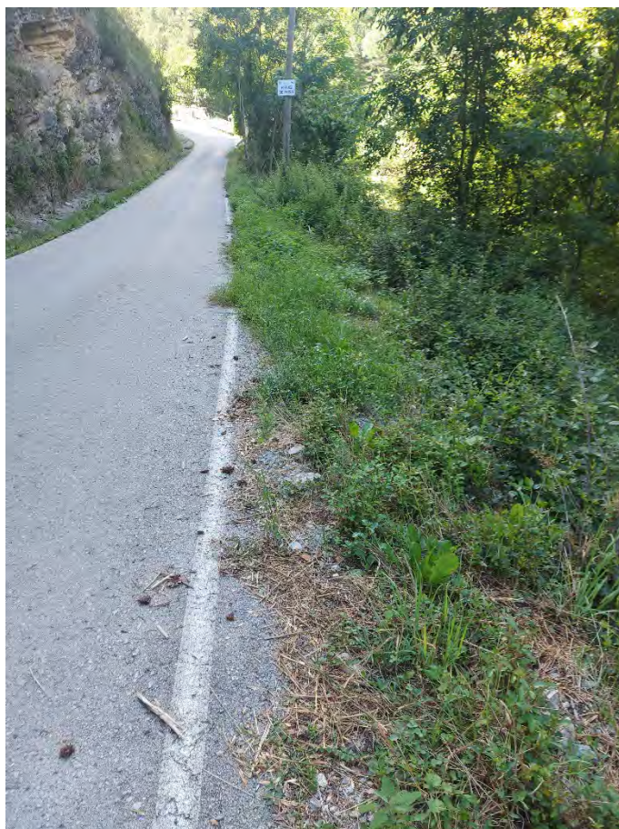
Fotografia núm. 7 - p.k. 1+250 Biona amb nova imposta i clavada 52 m
