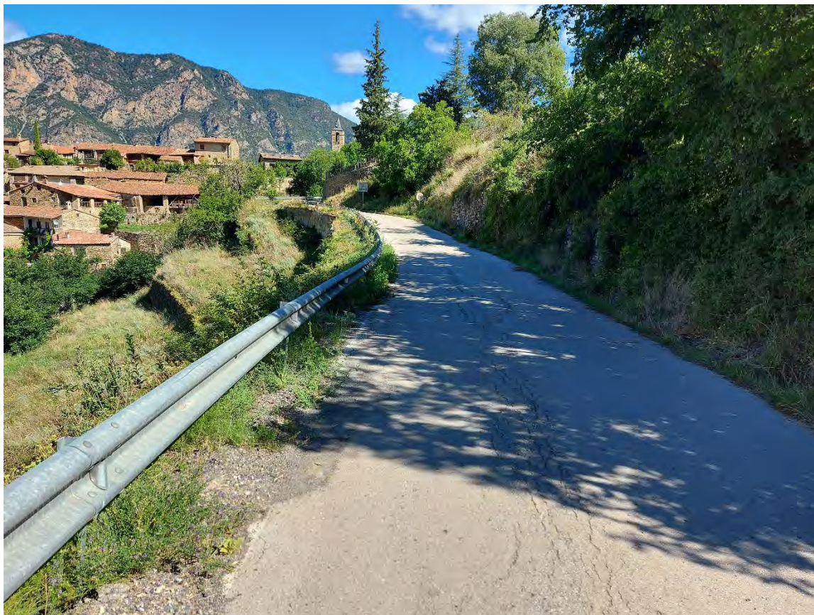
Fotografia núm. 9 - p.k. 1+450 Reparació de rotura calçada 34 m, desmuntatge i muntatge biona recuperada
