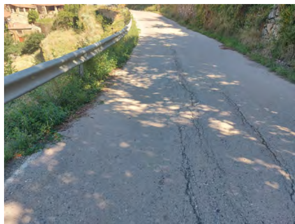
Flonjall p.k. 1+450, amb rotura de l'esplanada
