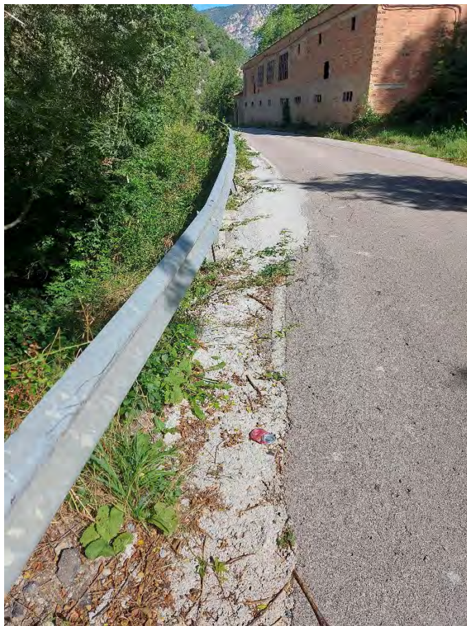
Fotografia núm. 5 - p.k. 0+510 Biona, desmuntatge, nova imposta 12 m
