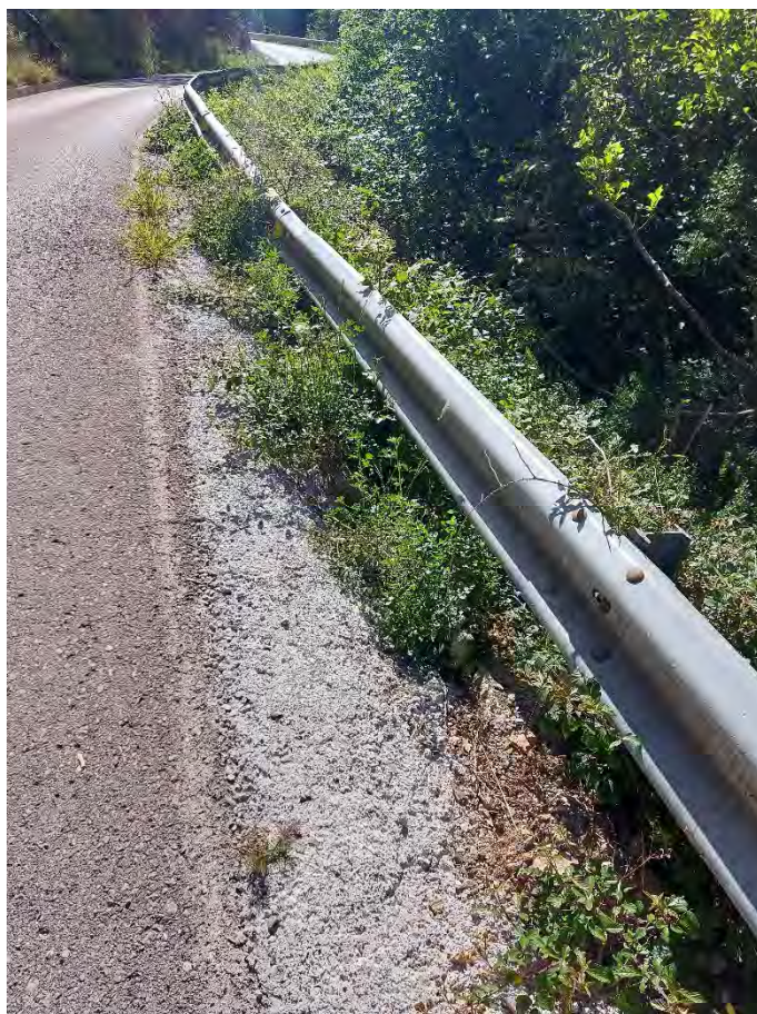
Fotografia núm. 3 - p.k. 0+300 Biona, desmuntatge i nova imposta 12 m
