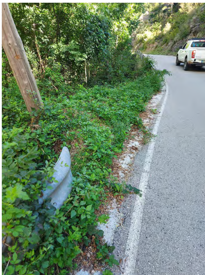
Fotografia núm. 4 - p.k. 0+400 Biona clavada 8 m
