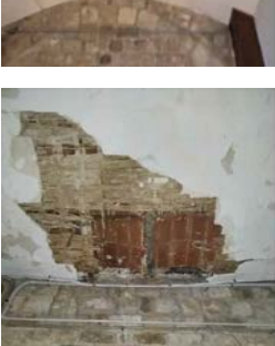
EH-PB-04 Forjat de bigueta metàl·lica, revoltó ceràmic
