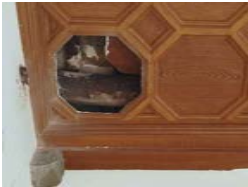
EH-PA-01 Forjat de bigueta metàl·lica i revoltó ceràmic
