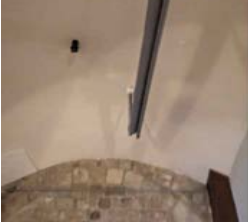
EH-PB-03 Volta de mocador
