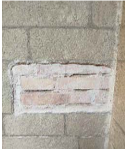
FH-P1-01 Arrebossat de galeria imitant carreus
