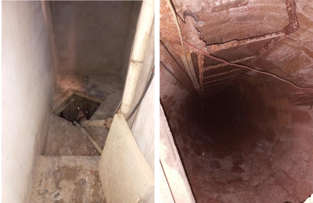
Pou existent en interior de l'edificació
