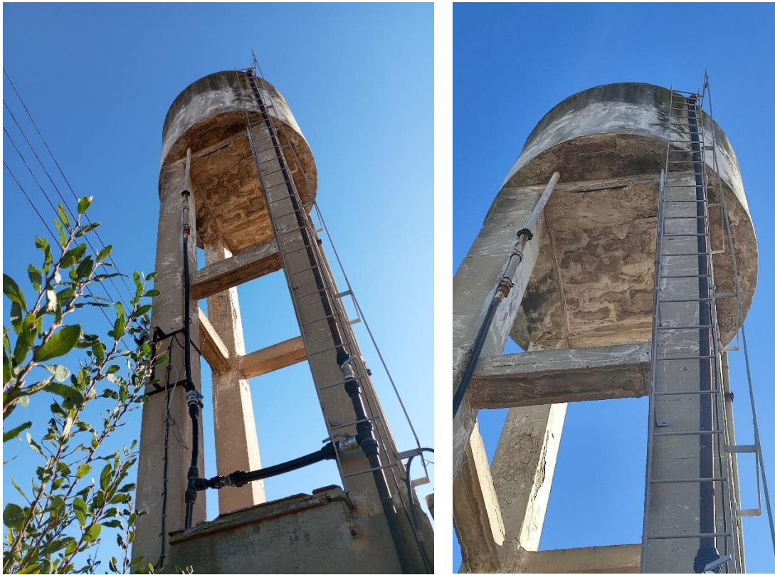
Dipòsit i estructura
