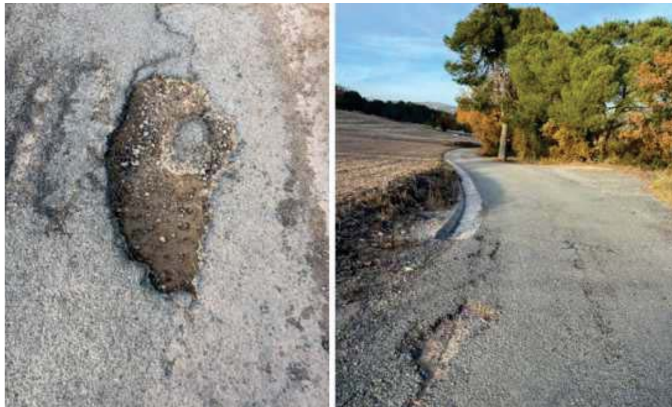
Figura 4. Presència de sots en el traçat del Camí de Les Feixes
