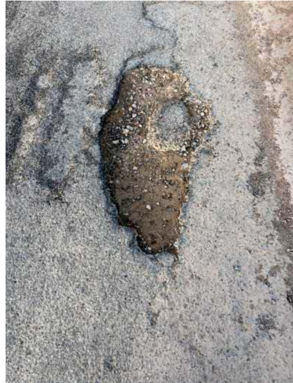
Figura 8. Detall de sot en el camí (Punt 5)
