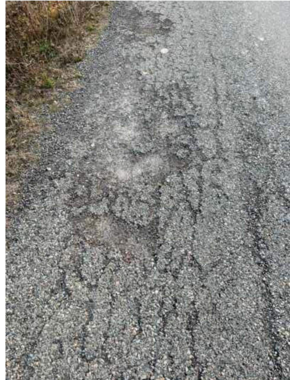
Figura 12. Detall de l'estat del reg asfàltic (Punt 7)
