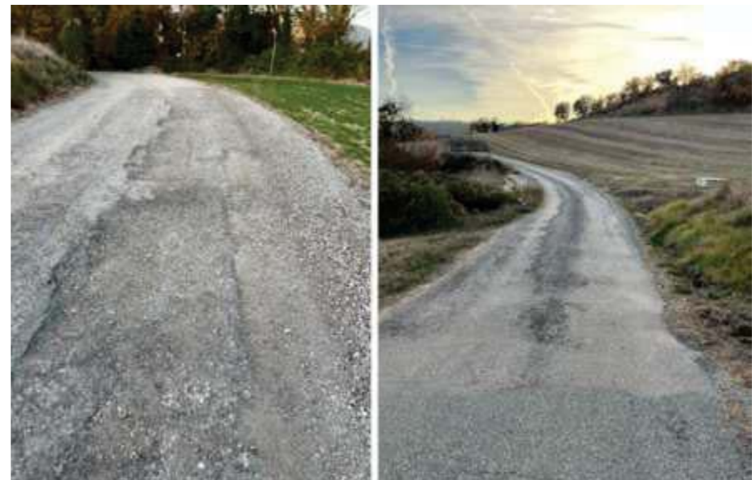
Figura 3. Presència de sots i acumulació d'aigua al Camí de Les Feixes
