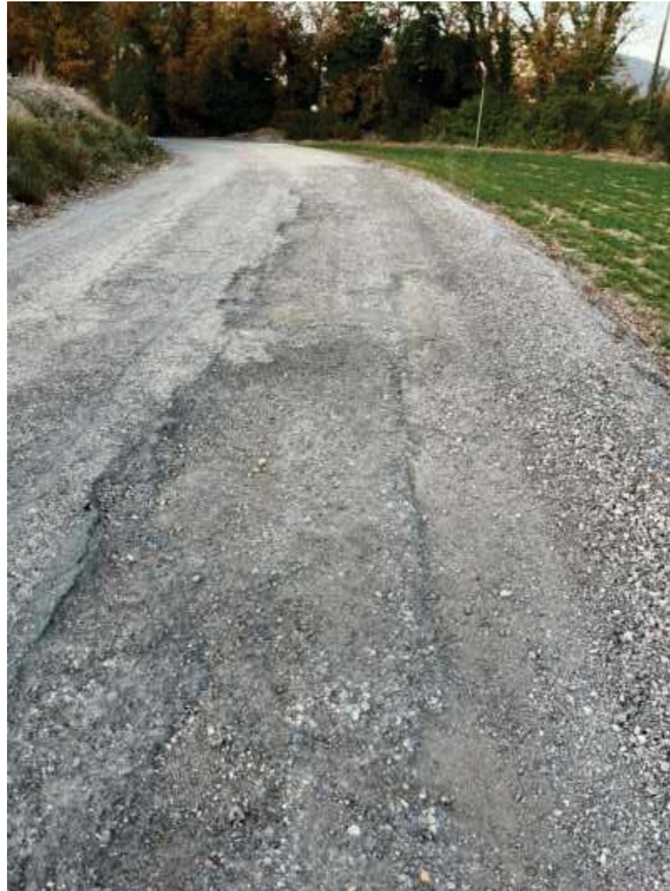
Figura 19. Detall reg asfàltic malmès (Punt 12)
