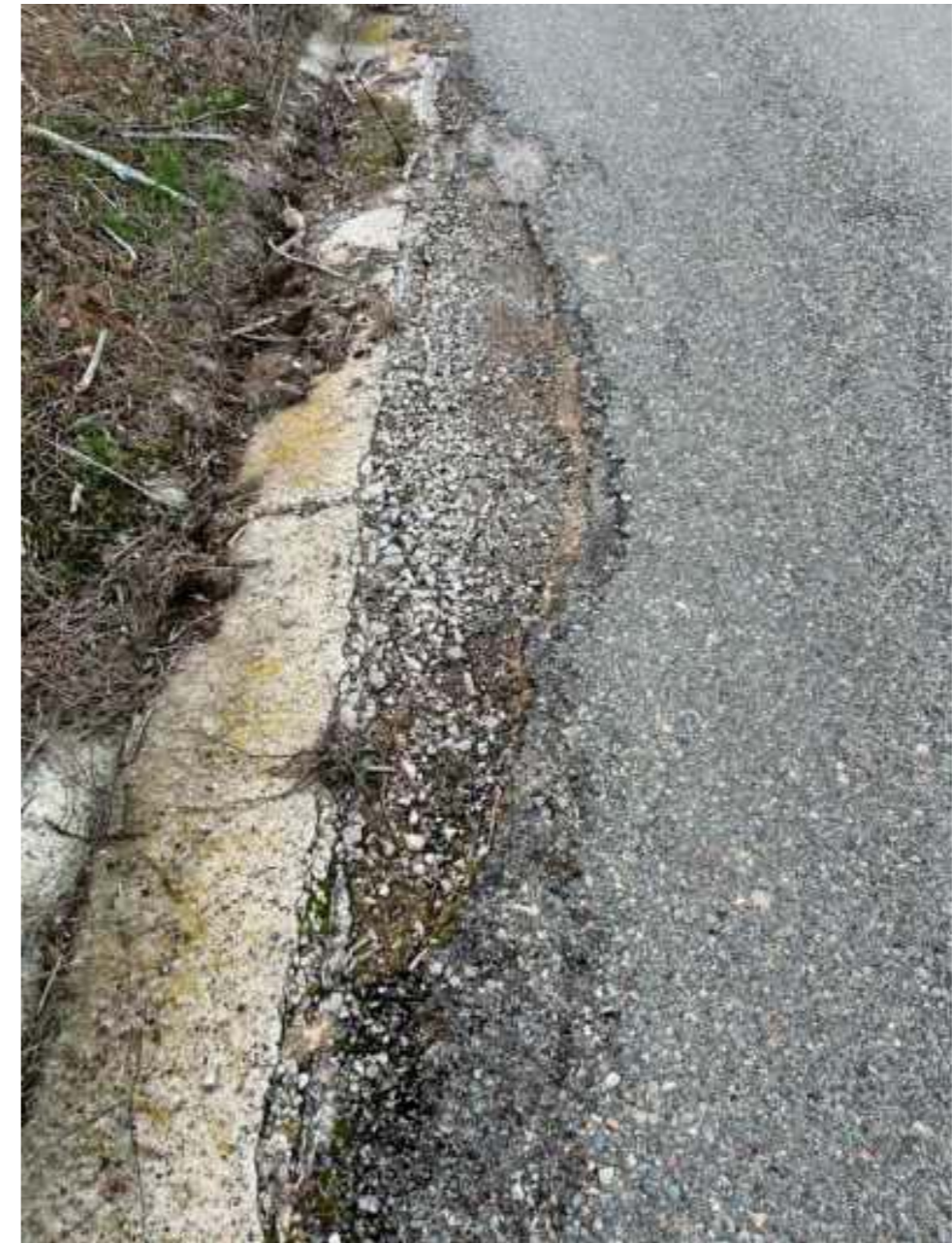
Figura 16. Detall reg asfàltic malmès (Punt 10)
