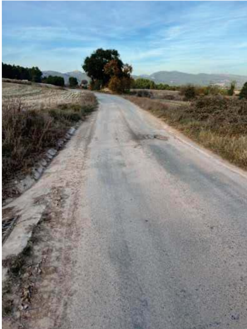
Figura 7. Part del camí amb embornal i cuneta existent (Punt 5)
