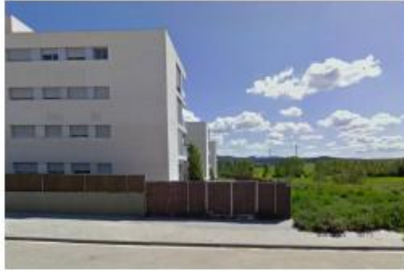
Il·lustració 2. Accés secundari a les zones comuns de l'edifici situat a la vorera sud de l'Av. Còrdova.
