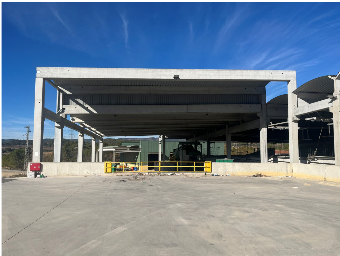
Fotografia 1 Alçat façana sud-est.
