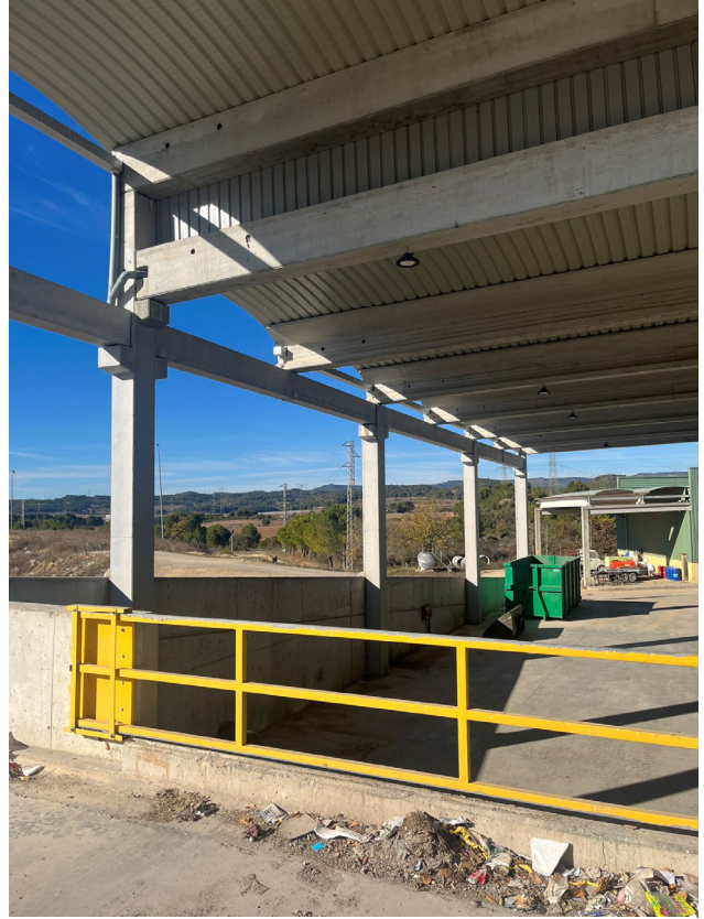
Fotografia 4 Vista des de la plataforma exterior de l'emplaçament de la planta de transferència.
