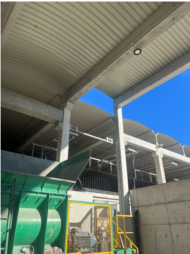
Fotografia 5 Vista interior de la façana sud est. 1/2
