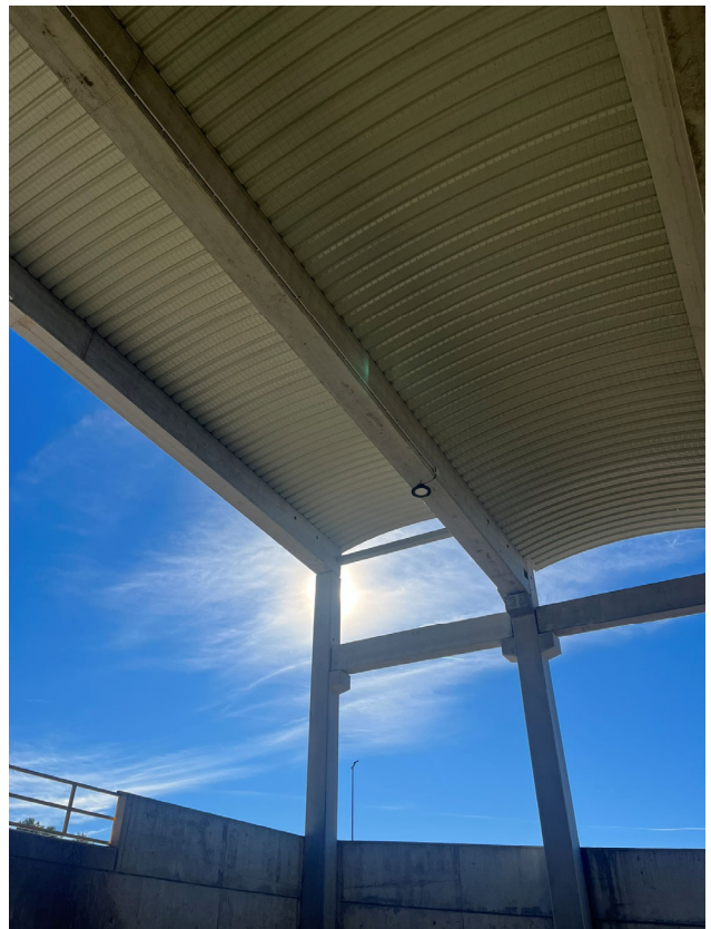
Fotografia 6 Vista interior de la façana sud est. 2/2
