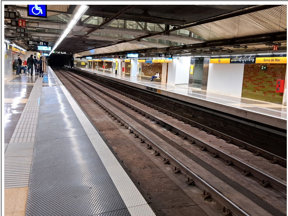
Nau d'andana estació Seva de Mar. Cuneta central acabada amb relliga
