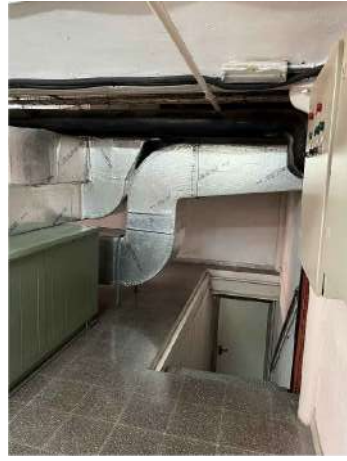
ACCÉS A SALA TÈCNICA ALTELL
