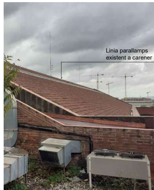
Vista 1. Estat actual desnivell entre coberta plana i inclinada
