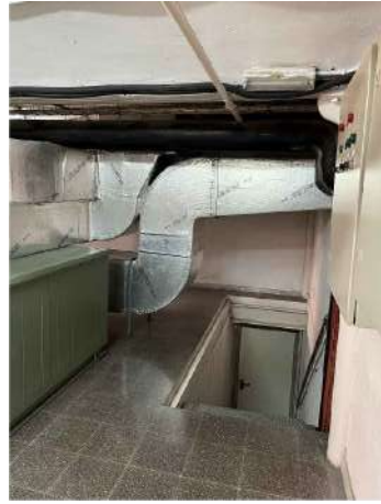
ACCÉS A SALA TÈCNICA ALTELL
