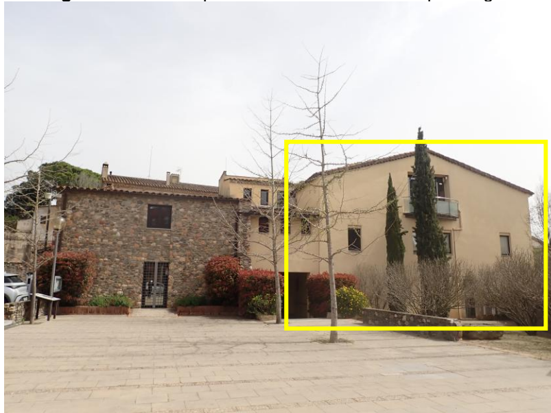
Figura 1. Edifici inspeccionat indicat amb el requadre groc
