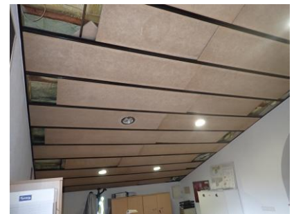
Obertura de plaques practicables a planta segona
