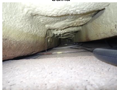
Projectat d'escuma de poliuretà a l'estructura de la planta segona
