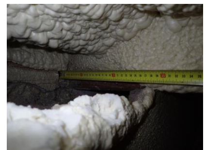
Extradossat en murs de planta segona
