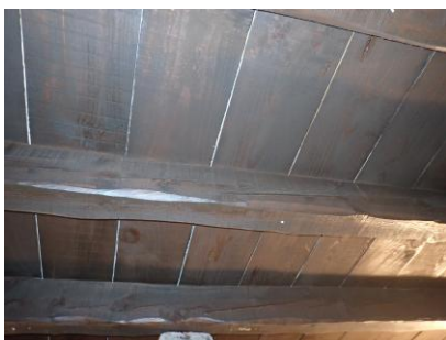
Exemple de bigues tenyides a planta baixa
