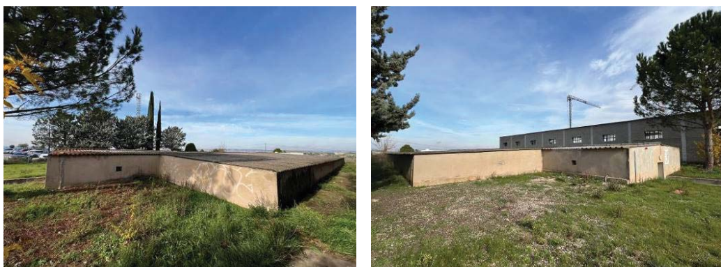
Vistes estat actual de la coberta de plaques de fibrociment amb amiant
