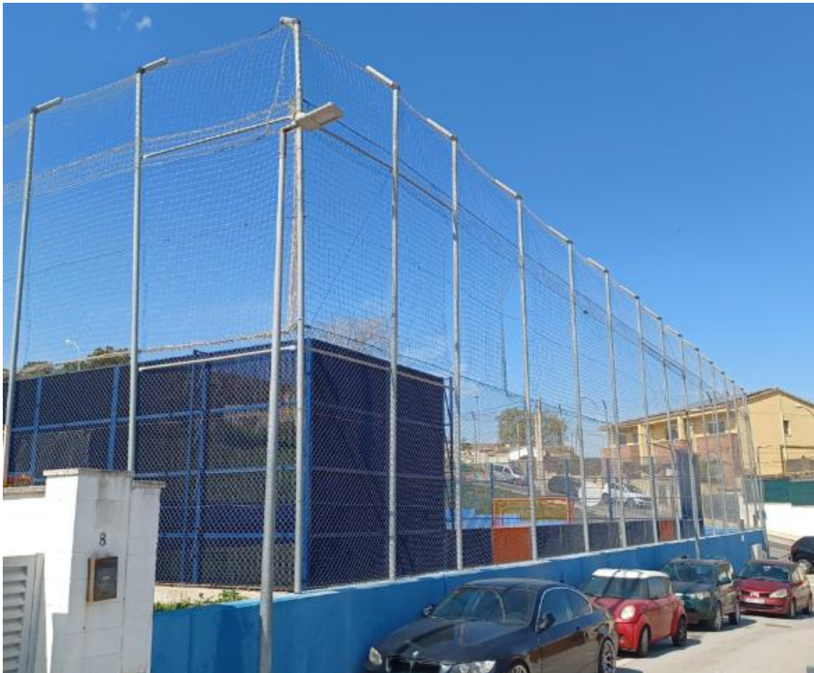
Vista exterior de la tanca i xarxa a retirar
