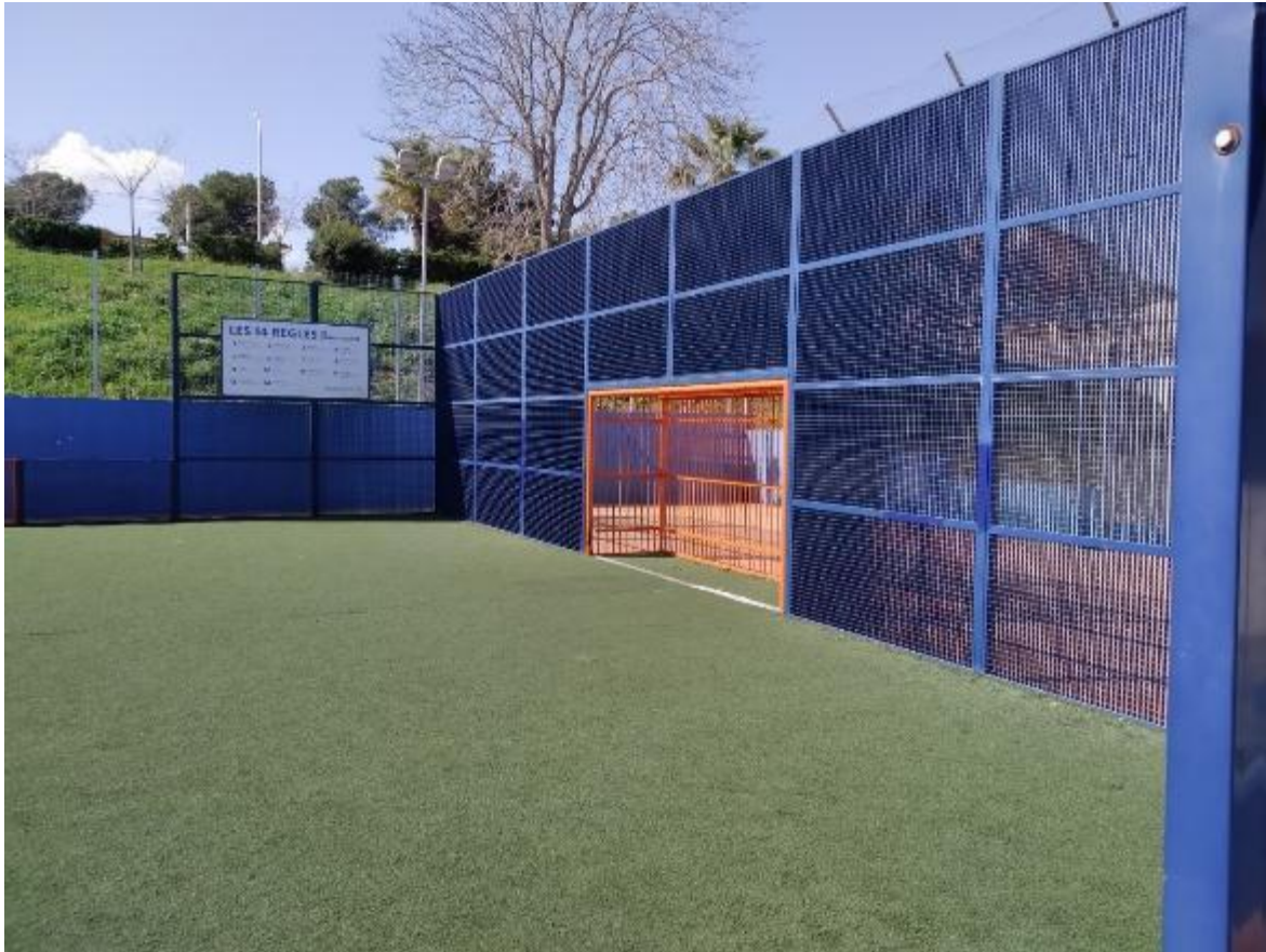
Vista interior de la porteria a modificar
