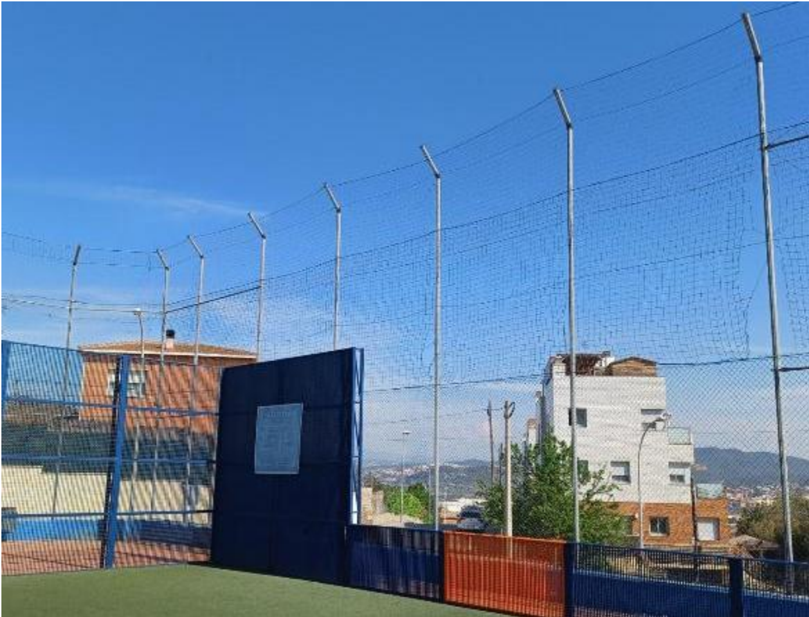
Vista interior de la tanca i xarxa a retirar
