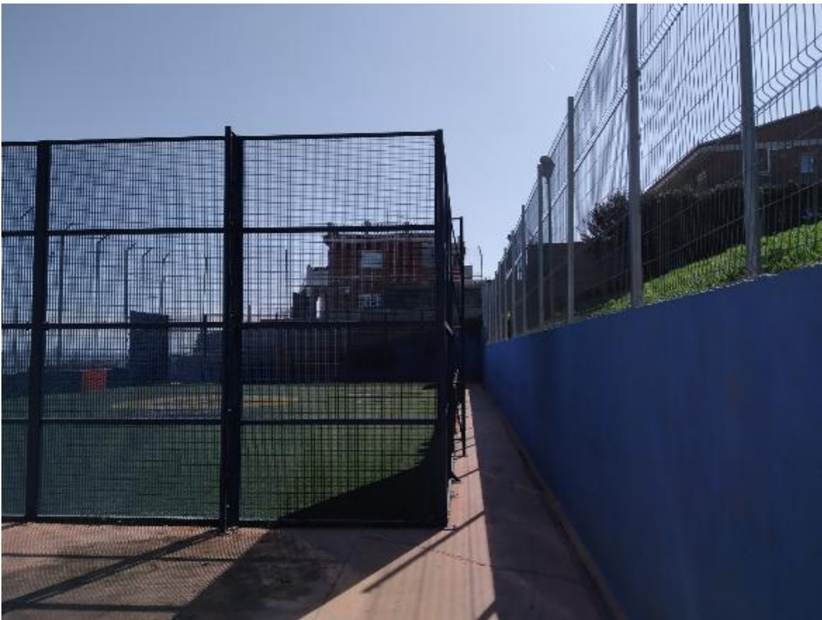
Vista del pas lateral del talús. Pas d'1,02m a 1,22m
