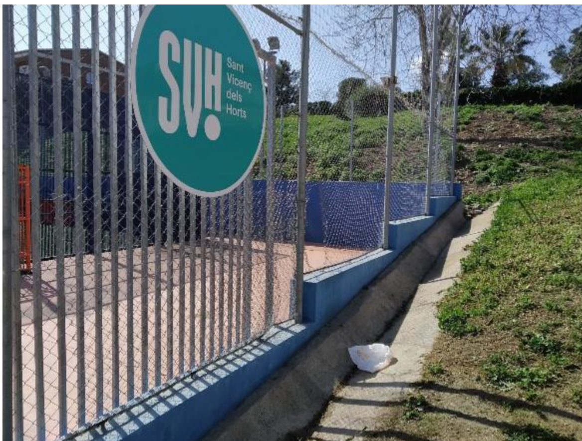
Detall trobada gespa terreny de joc amb vorera perimetral.
