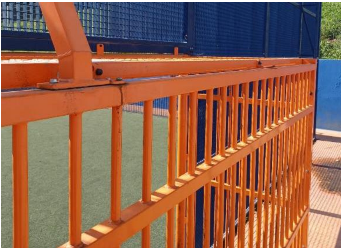
Detall de les fixacions amb cargols de la part posterior de la porteria
