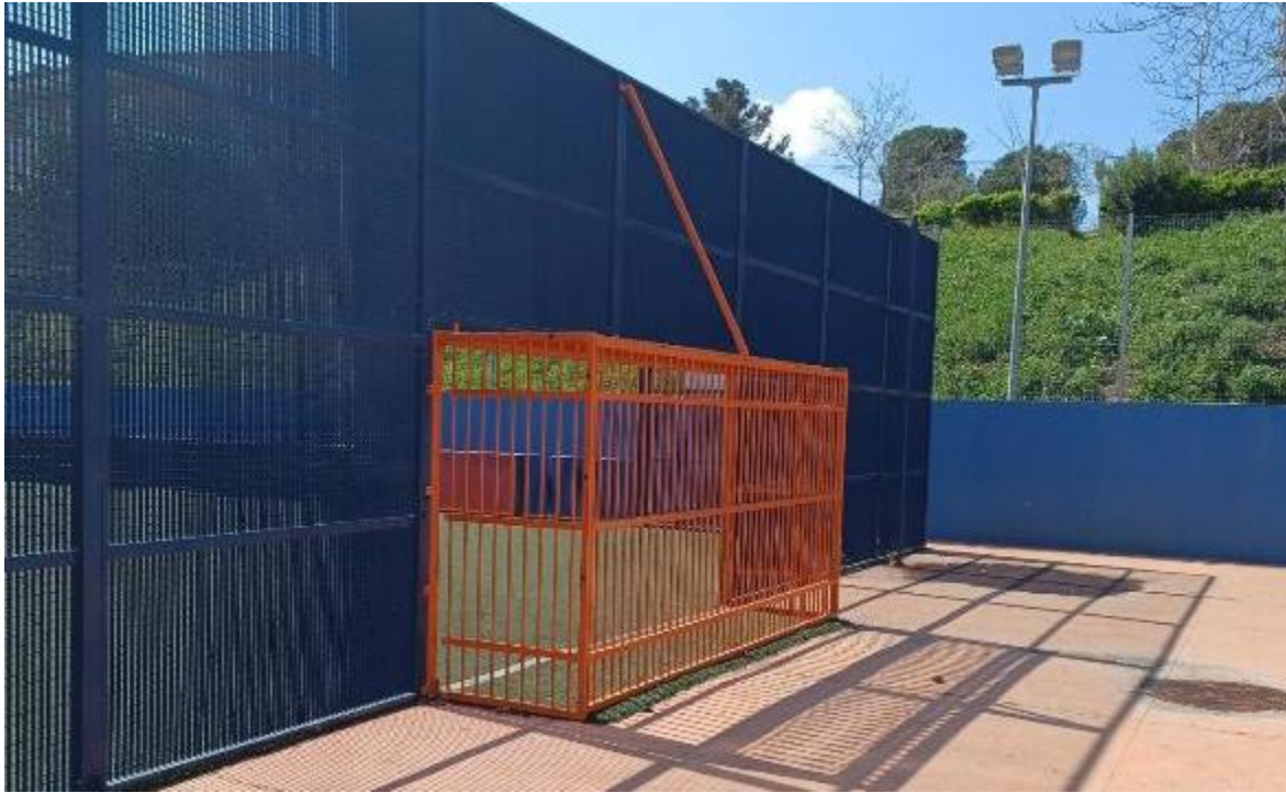
Vista exterior de la porteria a modificar
