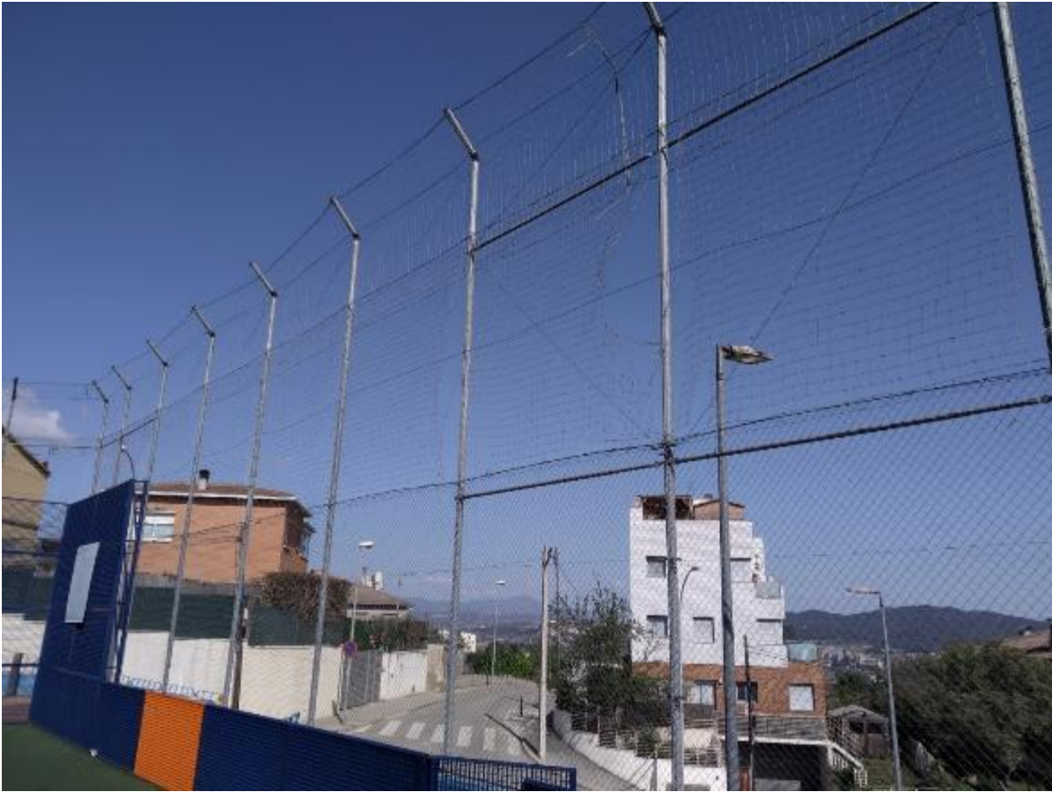
Vista interior de la tanca i xarxa a retirar
