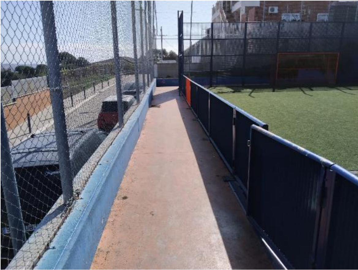
Vista del pas lateral de carrer. Pas d'1,35m a 1,56m
