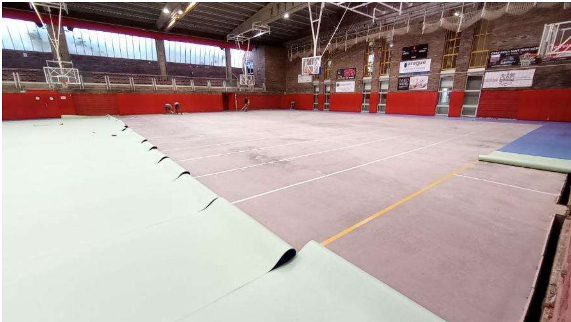
Paviment a retirar en pista Poliesportiu Francesc Calvet (rotlles i cinta adhesiva doble a retirar)
