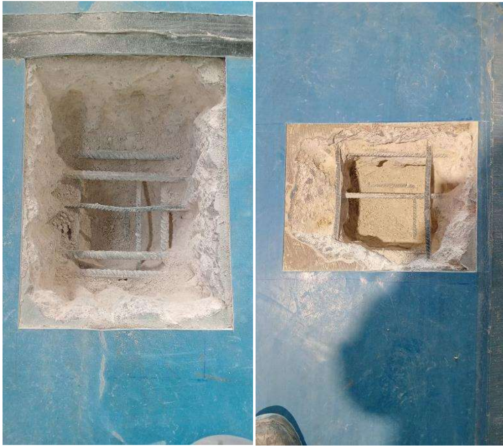
Cates realitzades en solera actual pista Centre Poliesportiu Ugalde
