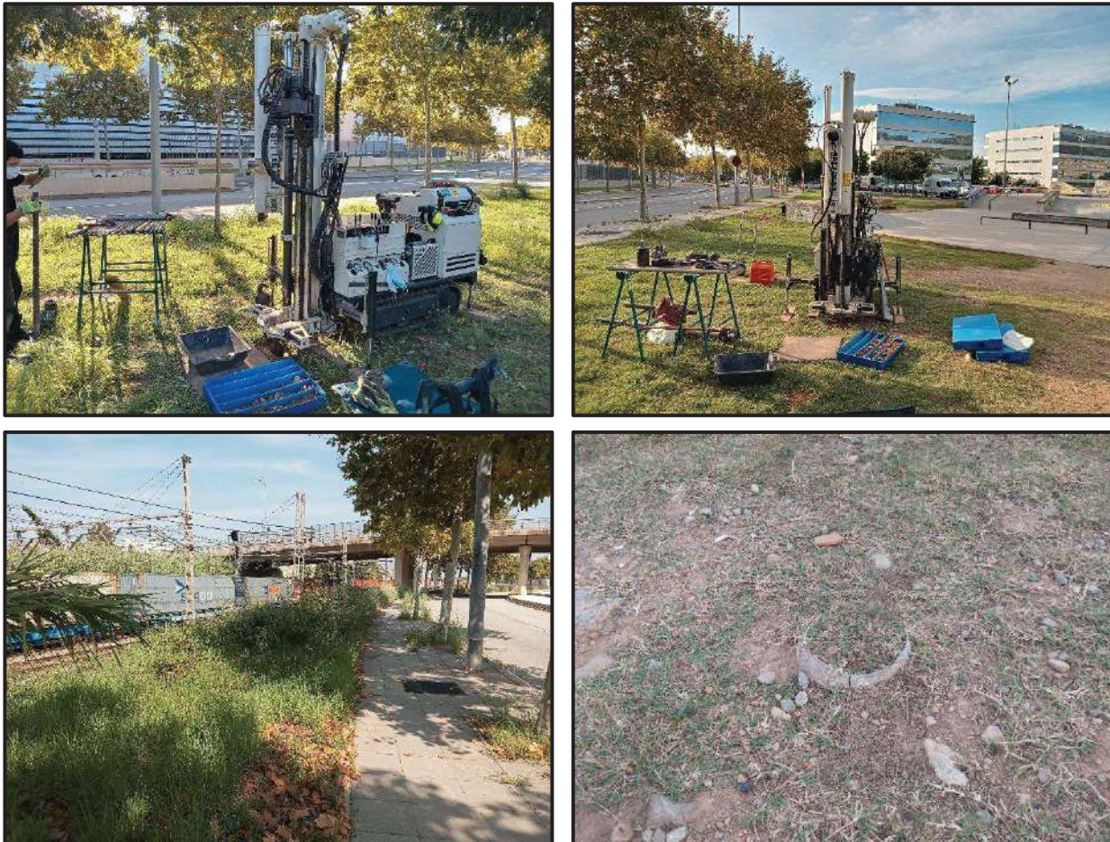
A dalt, diferents vistes de la zona d'estudi amb la maquinària de sondeigs emplaçada, amb el sondeig S-1 a l'esquerra i el sondeig S-2 a la dreta. A baix a l'esquerra, detall de la franja de terra més estreta situada al nord de la zona d'estudi, on la presència de serveis dificulta l'emplaçament de nous sondeigs. A la dreta, detall de restes d'uralita en superfície.
