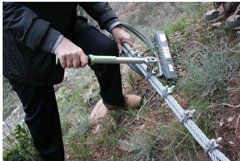
Figura 1. Comprovació de la força d'apretada en un premsacables amb clau dinamomètrica.
