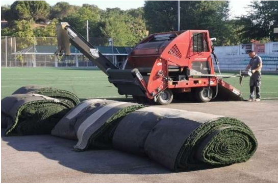
Estat en el que queden els rotllos de gespa artificial una vegada surten de la màquina.
