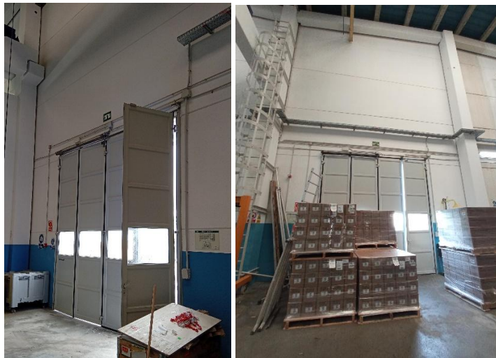
Imatge 7 Portes industrials nau procés vista interior
