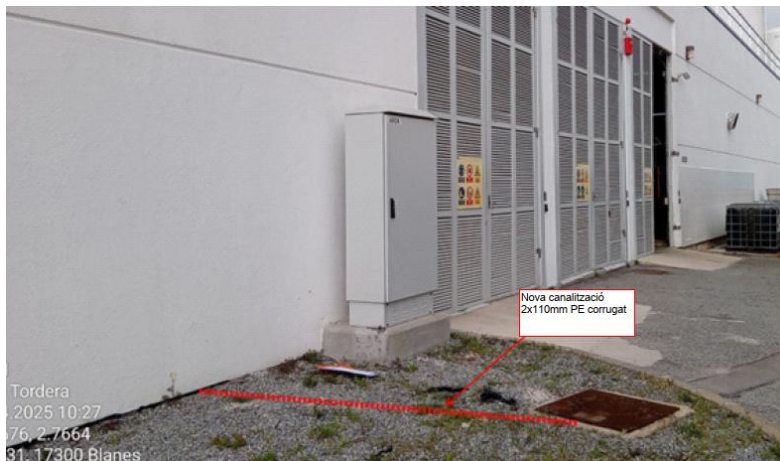
Imatge 13 Canalització serveis
