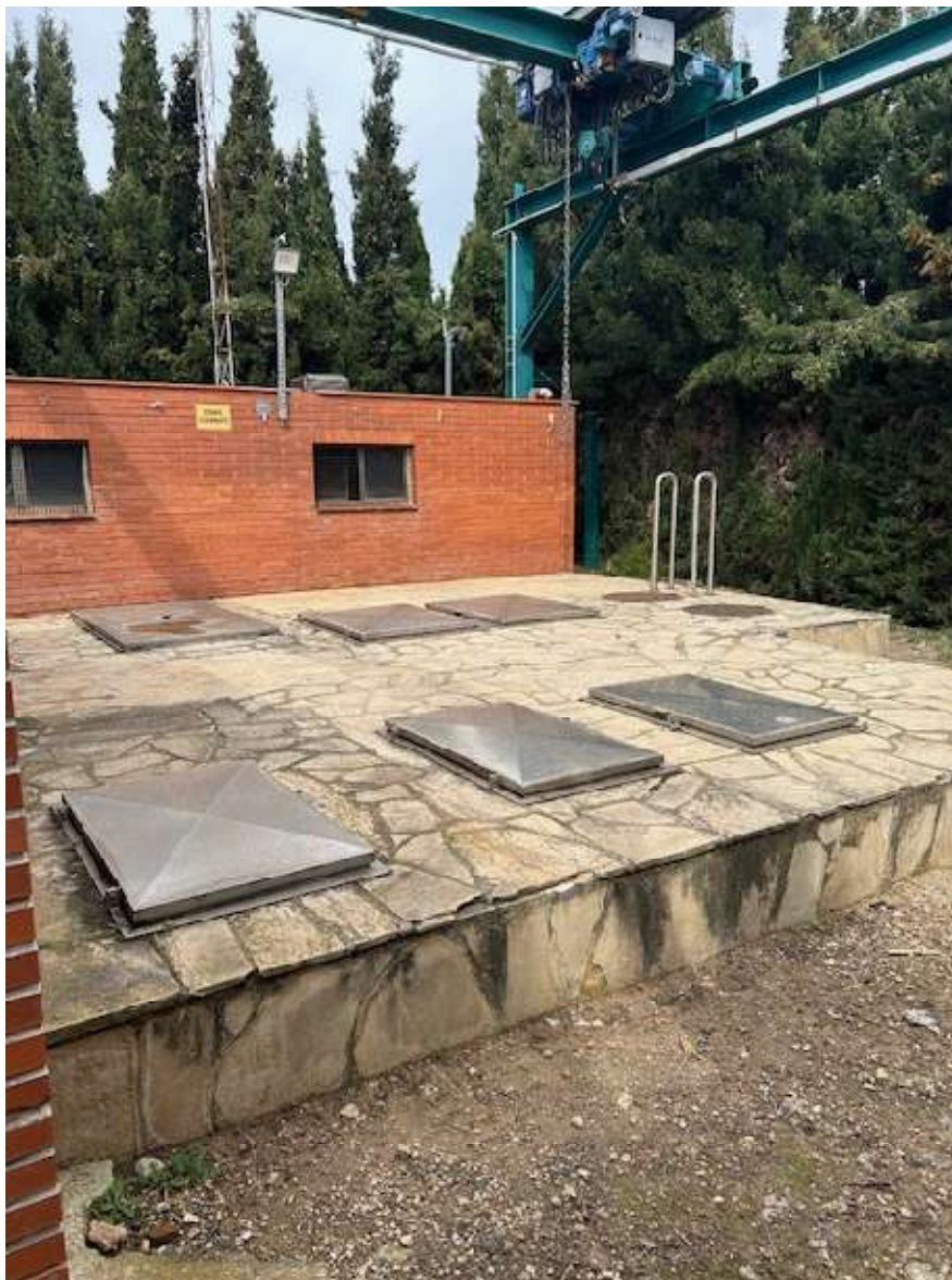
Foto Núm 3: Tapes d'accés a les bombes de l'EB la Mora on aniran les tapes assistides individuals.
