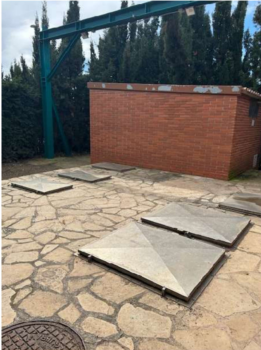
Foto Núm 2: Vista de les tapes de l'aljub de l'EB La Mora..
