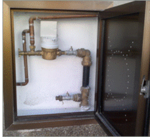
Exemples d'instal·lacions de comptador amb mòdul de telectura incorporat
